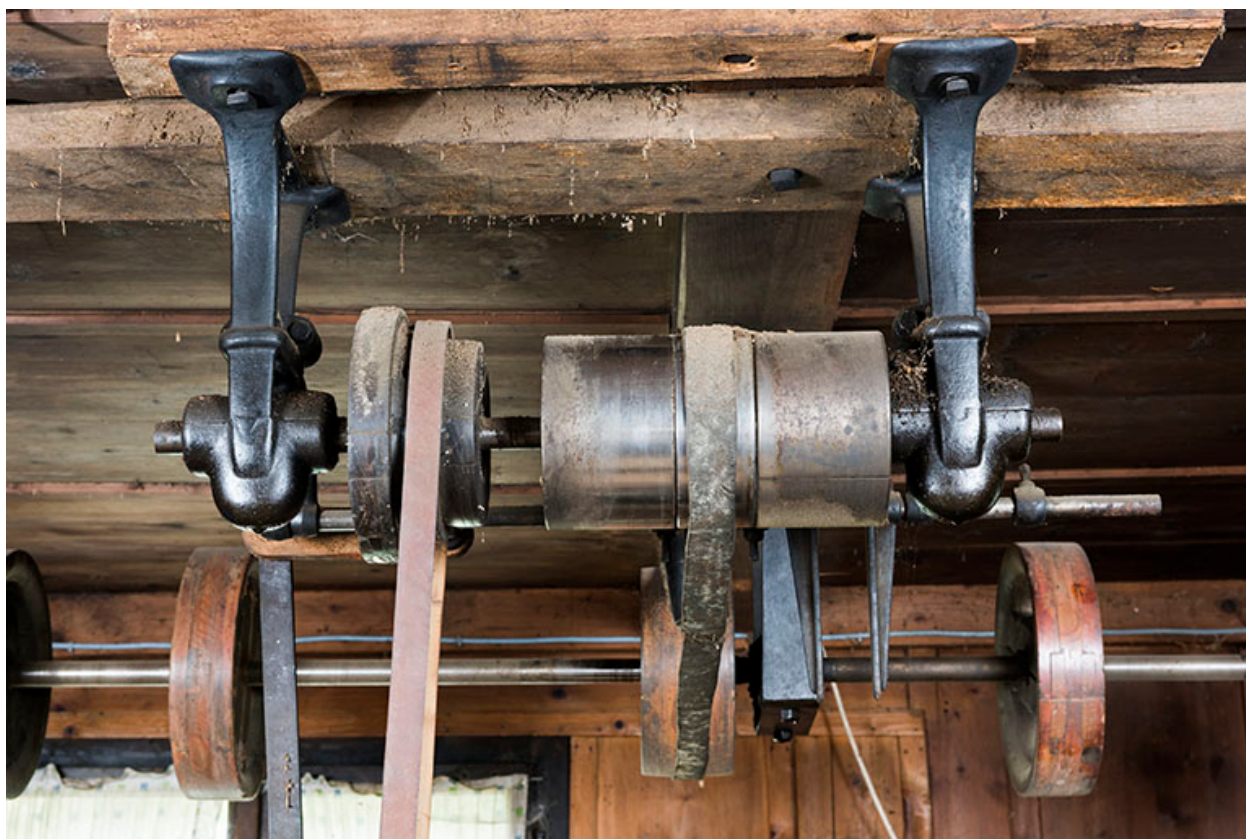
Système de transmission au plafond.
