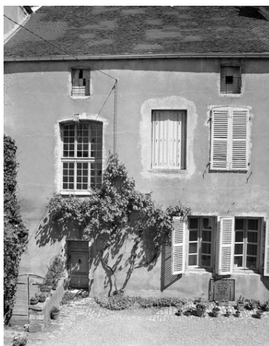
Façade postérieure de l'édifice principal. Phot. Yves Sancey IVR43_19917000043X
