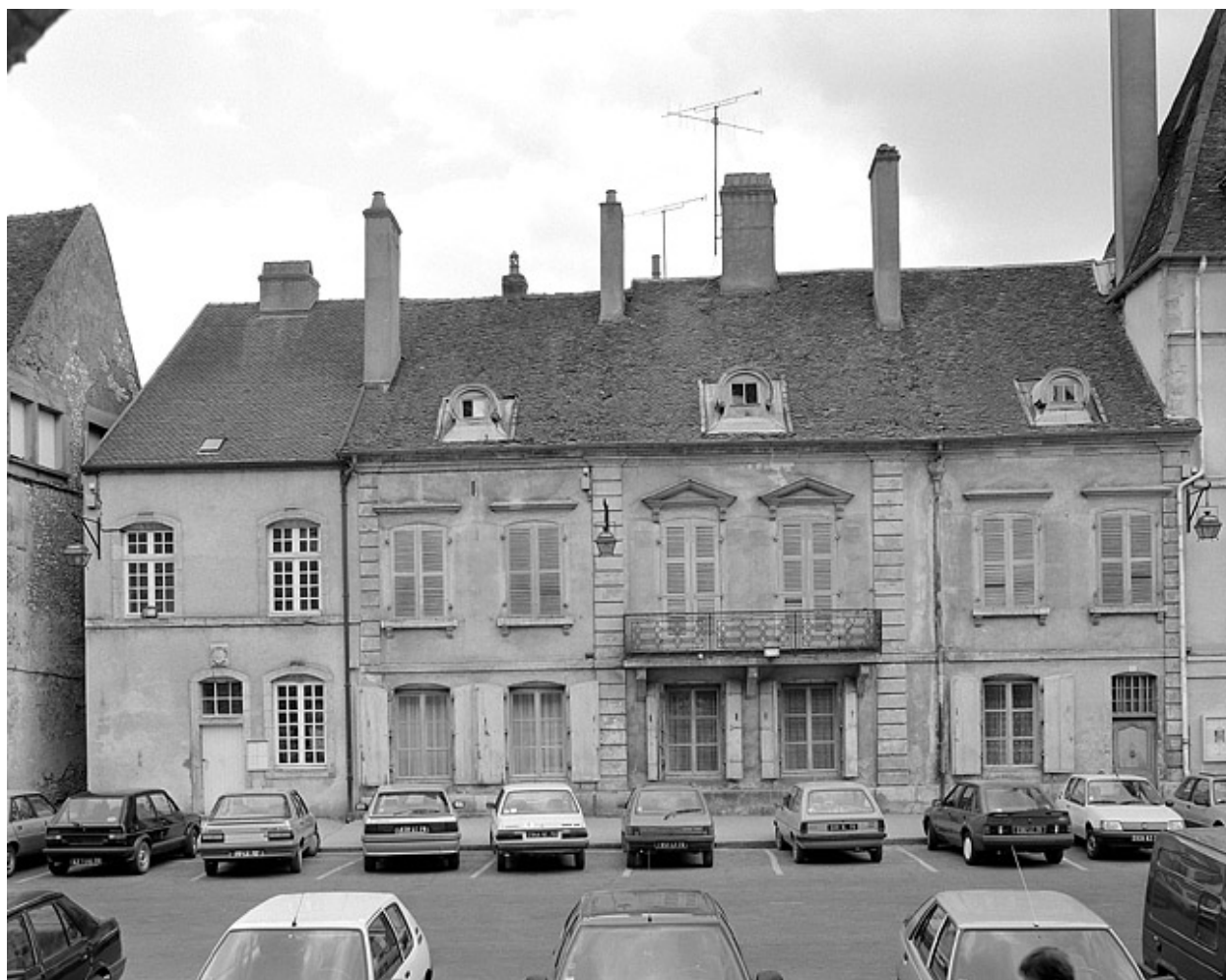
Façade antérieure de l'édifice principal, de face.
