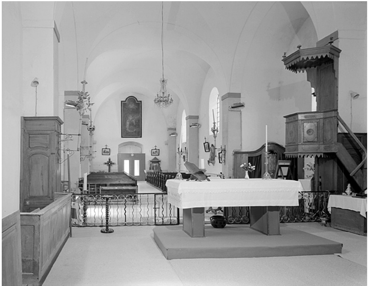
Elévation intérieure nord vue depuis le chœur.
