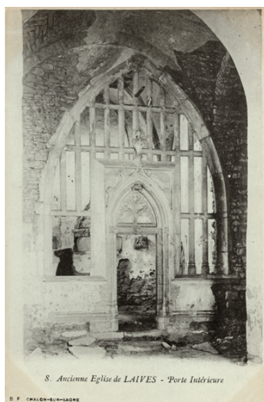
Vue ancienne. Autr. auteur inconnu IVR26_20237100154NUC4A
