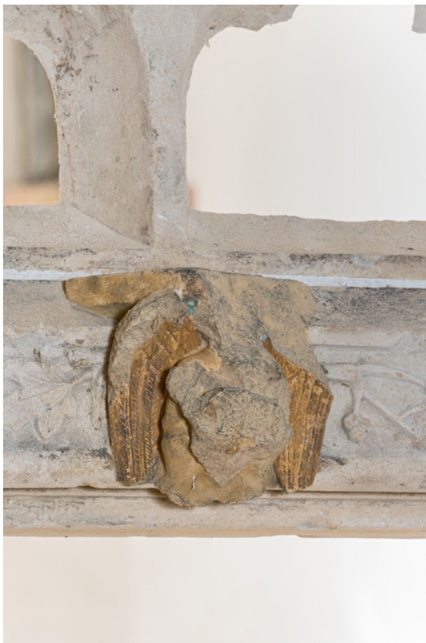
Détail : ange porteur d'écu du linteau.
