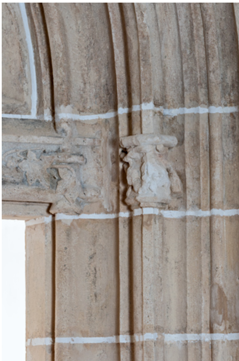
Détail : piédroit, partie supérieure.
