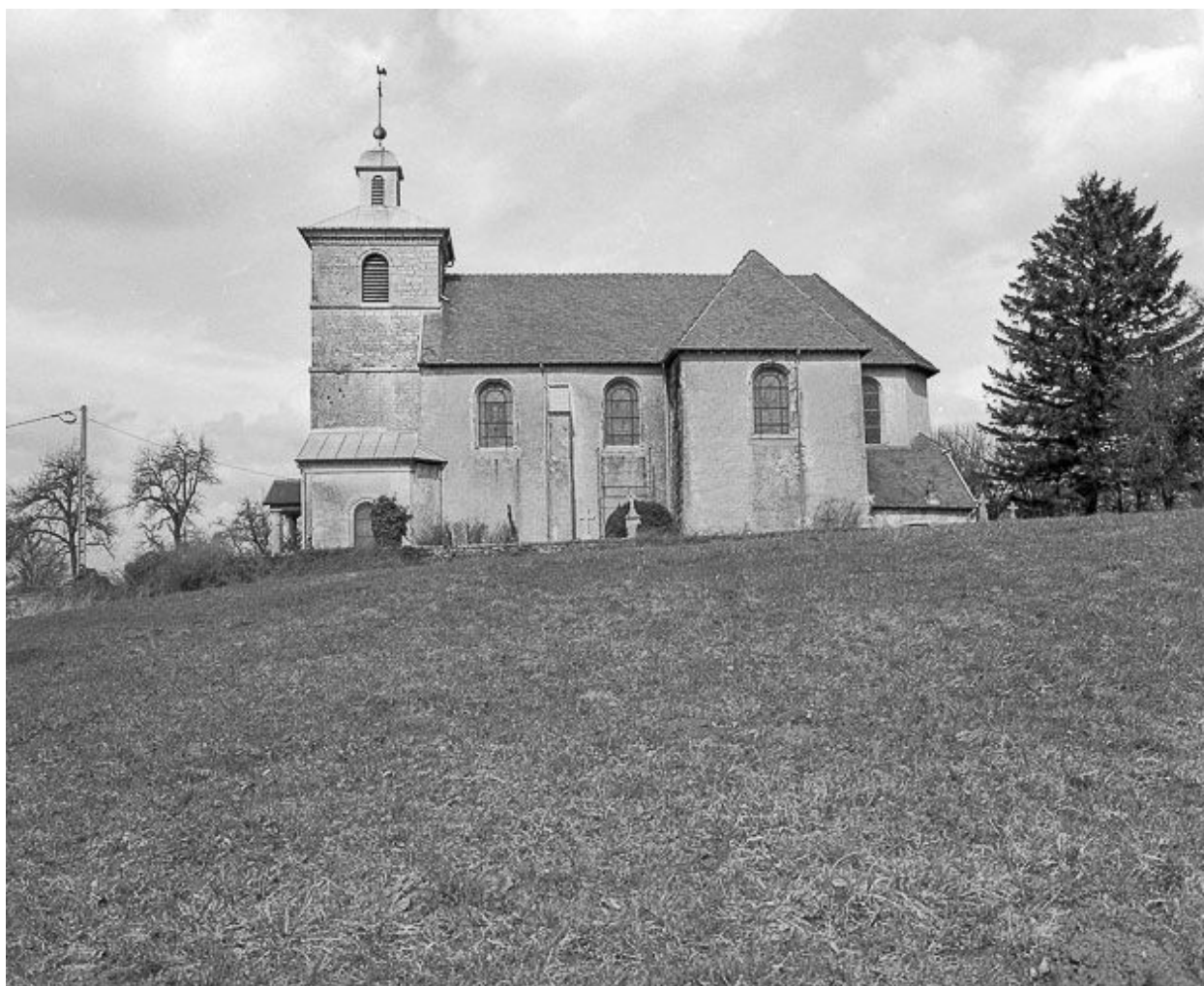
Façade latérale droite.
