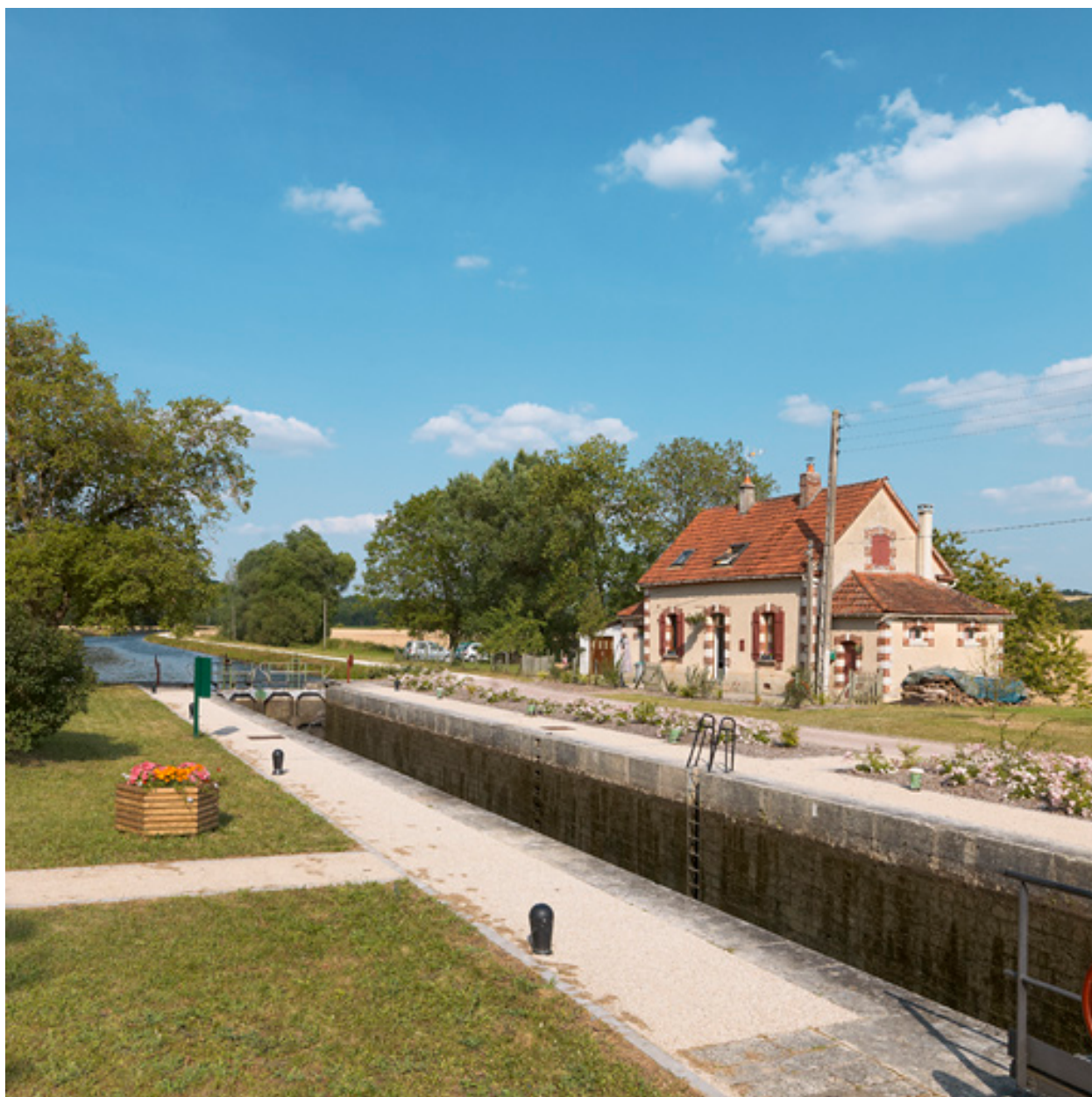
Vue d'aval du site d'écluse.
