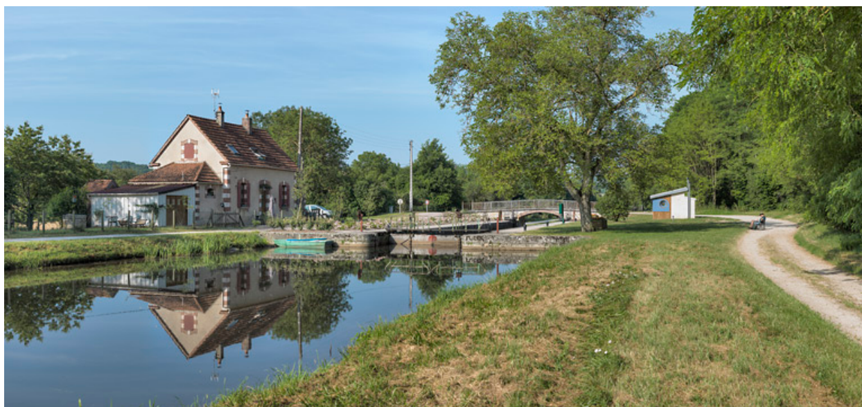
Vue d'amont du site d'écluse.
