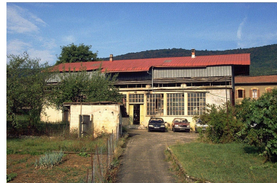
Ancienne tournerie. Phot. Laurent Poupard IVR43_19913901092ZA
