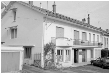
Bureau et logement patronal. Phot. Laurent Poupard IVR43_19913901089Z
