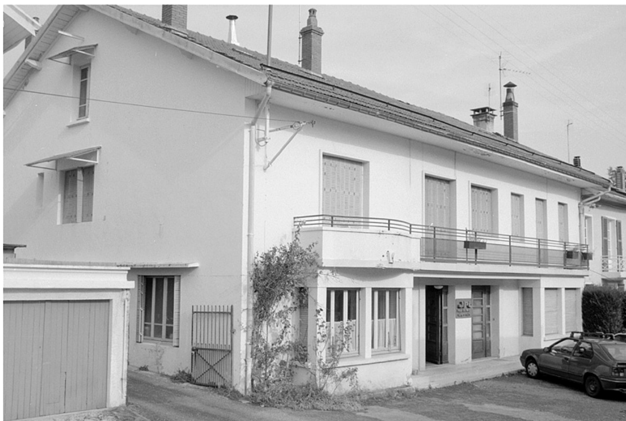
Bureau et logement patronal.
