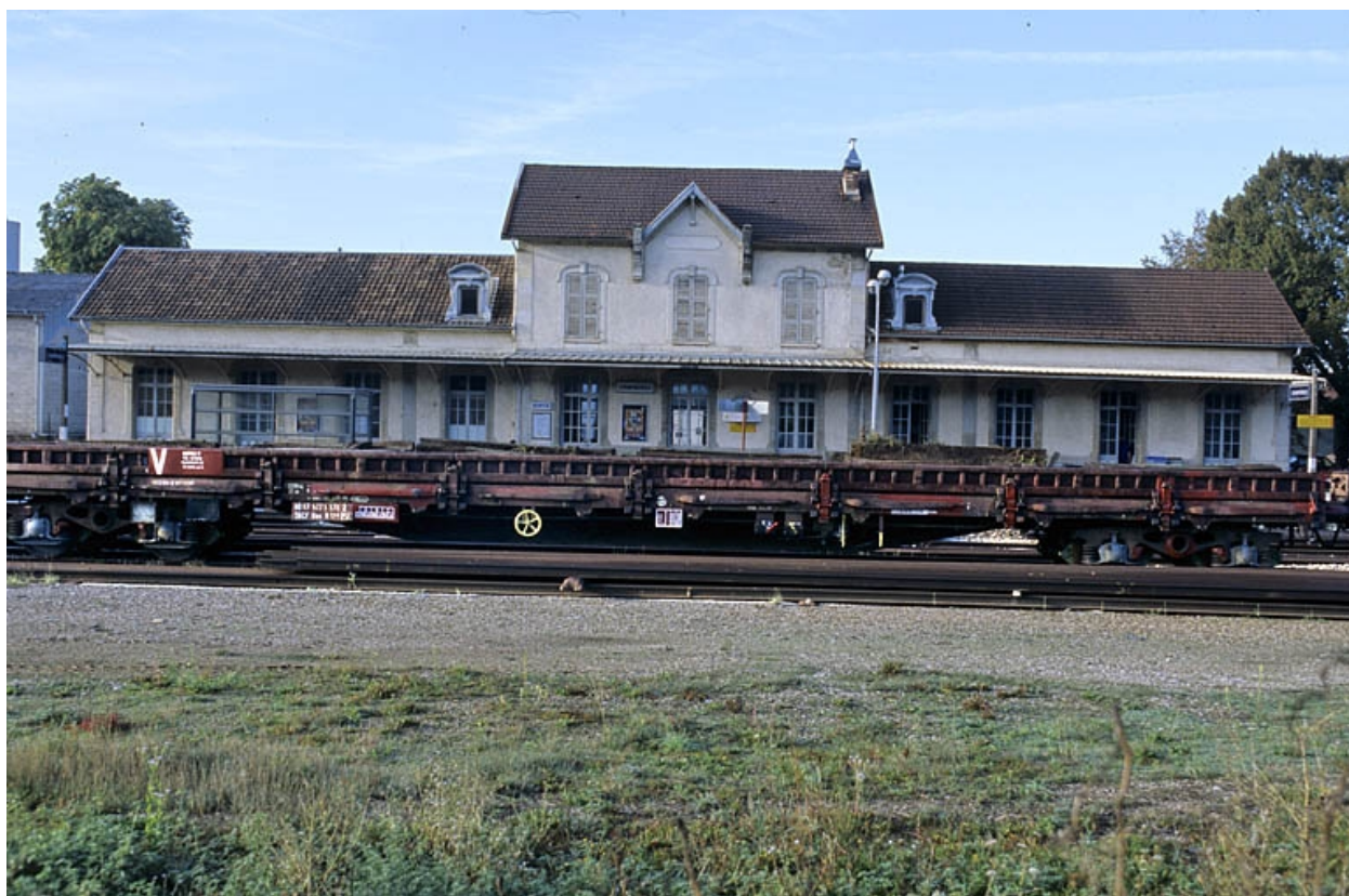
Bâtiment des voyageurs : façade postérieure.
