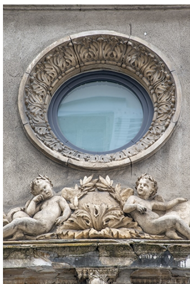
Vue rapprochée. Phot. Jérôme Mongreville IVR43_20223900318NUC4A
