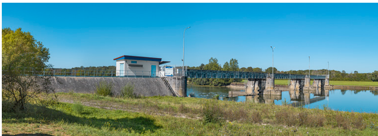
Vue d'ensemble d'amont depuis Charnay-lès-Chalon, rive gauche.
