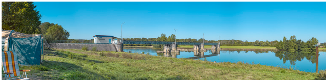
Vue d'ensemble d'amont depuis Charnay-lès-Chalon, rive gauche.
