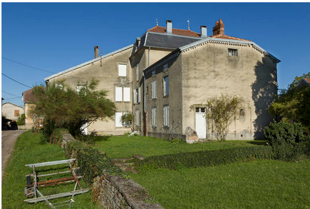
Maison, rue du Château, façades postérieures.
