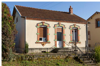
Maison d'ouvrier. Phot. Sonia Dourlot IVR43_20157000647NUC2A
