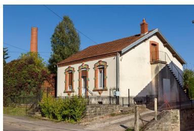
Logement d'ouvrier. Phot. Sonia Dourlot IVR43_20157000648NUC2A
