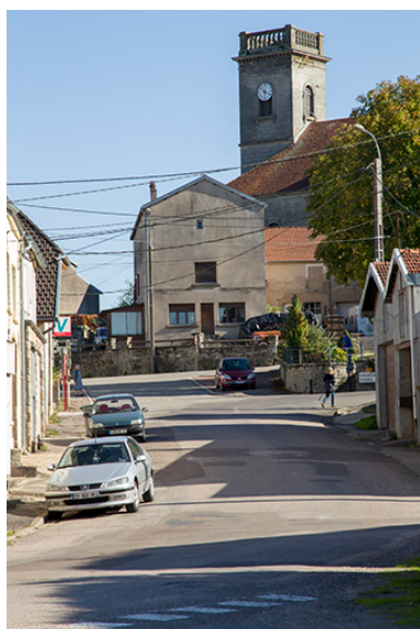
Vue générale. Phot. Sonia Dourlot IVR43_20157000637NUC2A
