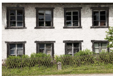
Détail de la façade est de l'atelier. Phot. Jérôme Mongreville IVR43_20122501151NUC4A
