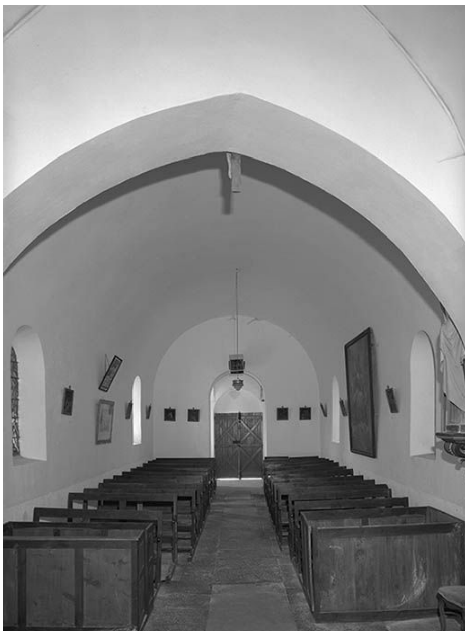
Vue intérieure prise du chœur
