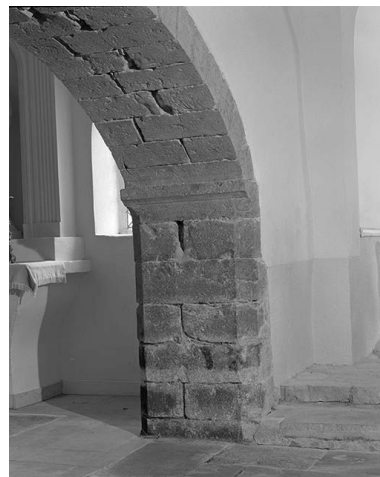
Arcade de la chapelle gauche : support droit Phot. Jean-Luc Duthu IVR26_19955801102X
