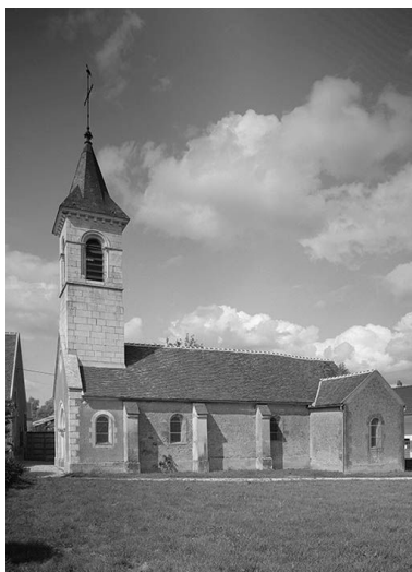
Elévation droite Phot. Jean-Luc Duthu IVR26_19955801113V
