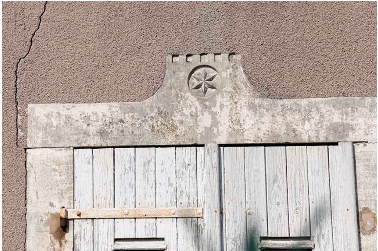
Détail du décor sur les linteaux.
