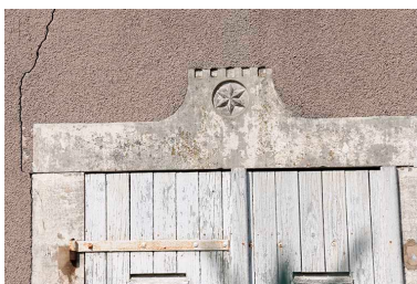
Détail du décor sur les linteaux. Phot. Jérôme Mongreville IVR43_20167000487NUC4A
