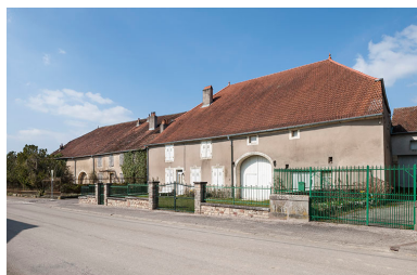
Vue d'ensemble. Phot. Jérôme Mongreville IVR43_20167000483NUC4A
