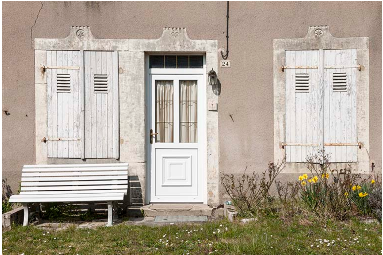
Porte d'entrée, façade principale.
