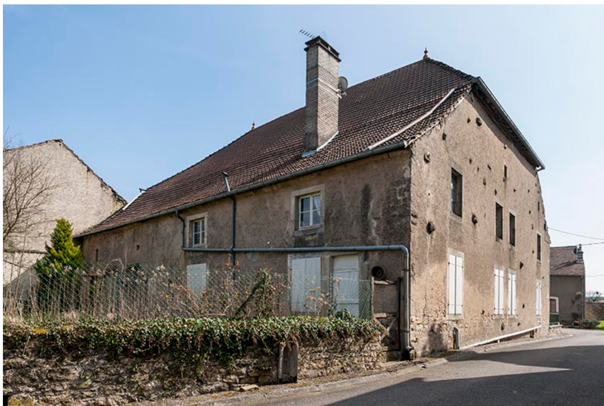
Façade postérieure et mur pignon ouest.
