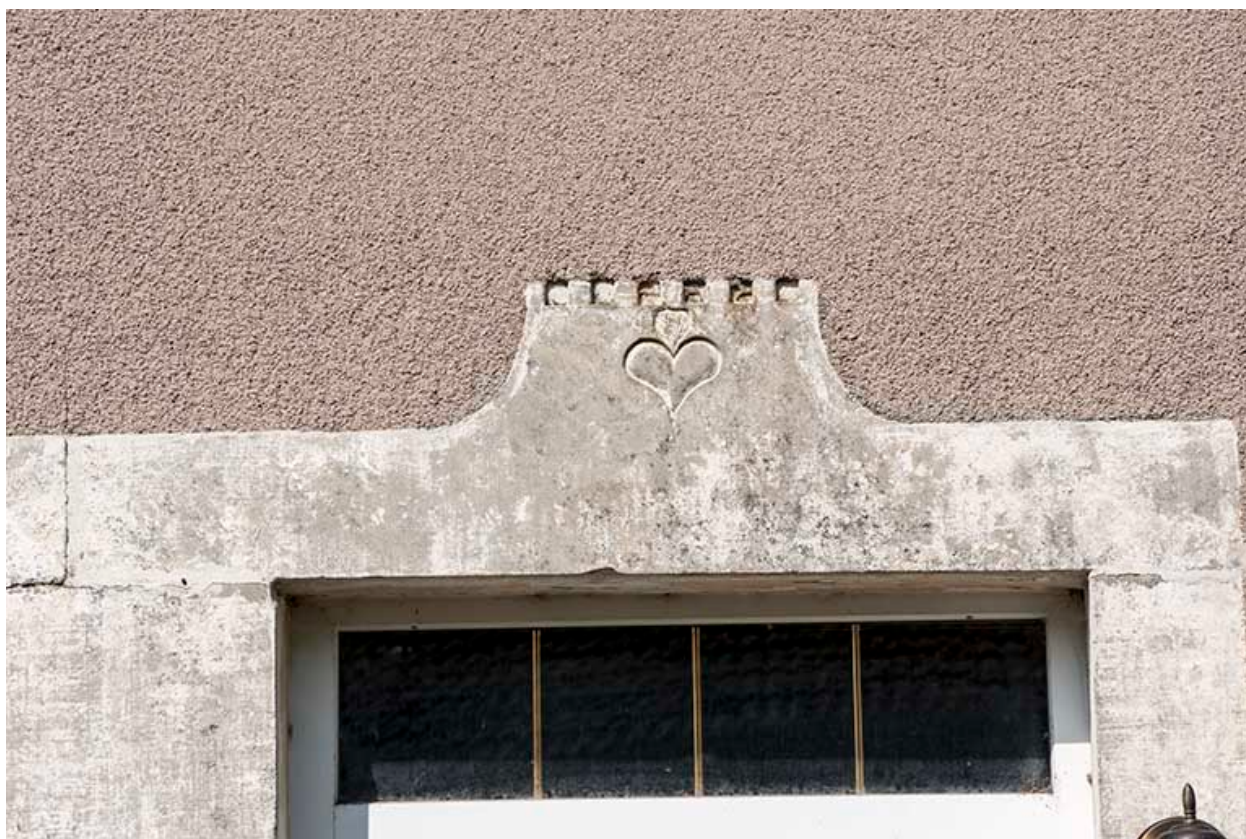
Détail du décor sur les linteaux.
