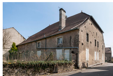
Façade postérieure et mur pignon ouest. Phot. Jérôme Mongreville IVR43_20167000491NUC4A
