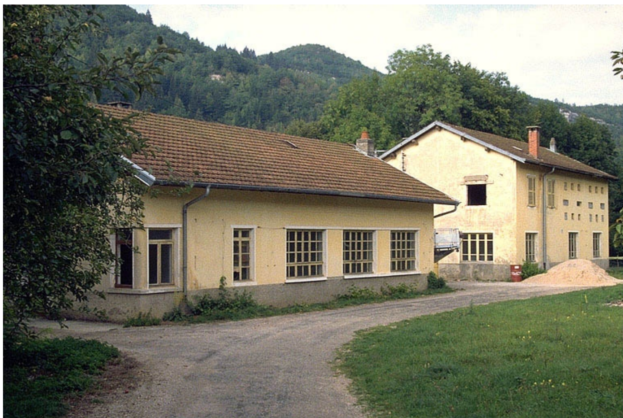
Bâtiments depuis l'entrée.
