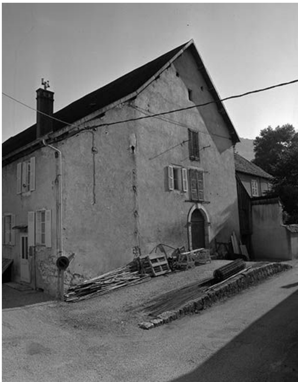
Façade antérieure de la chapelle.
