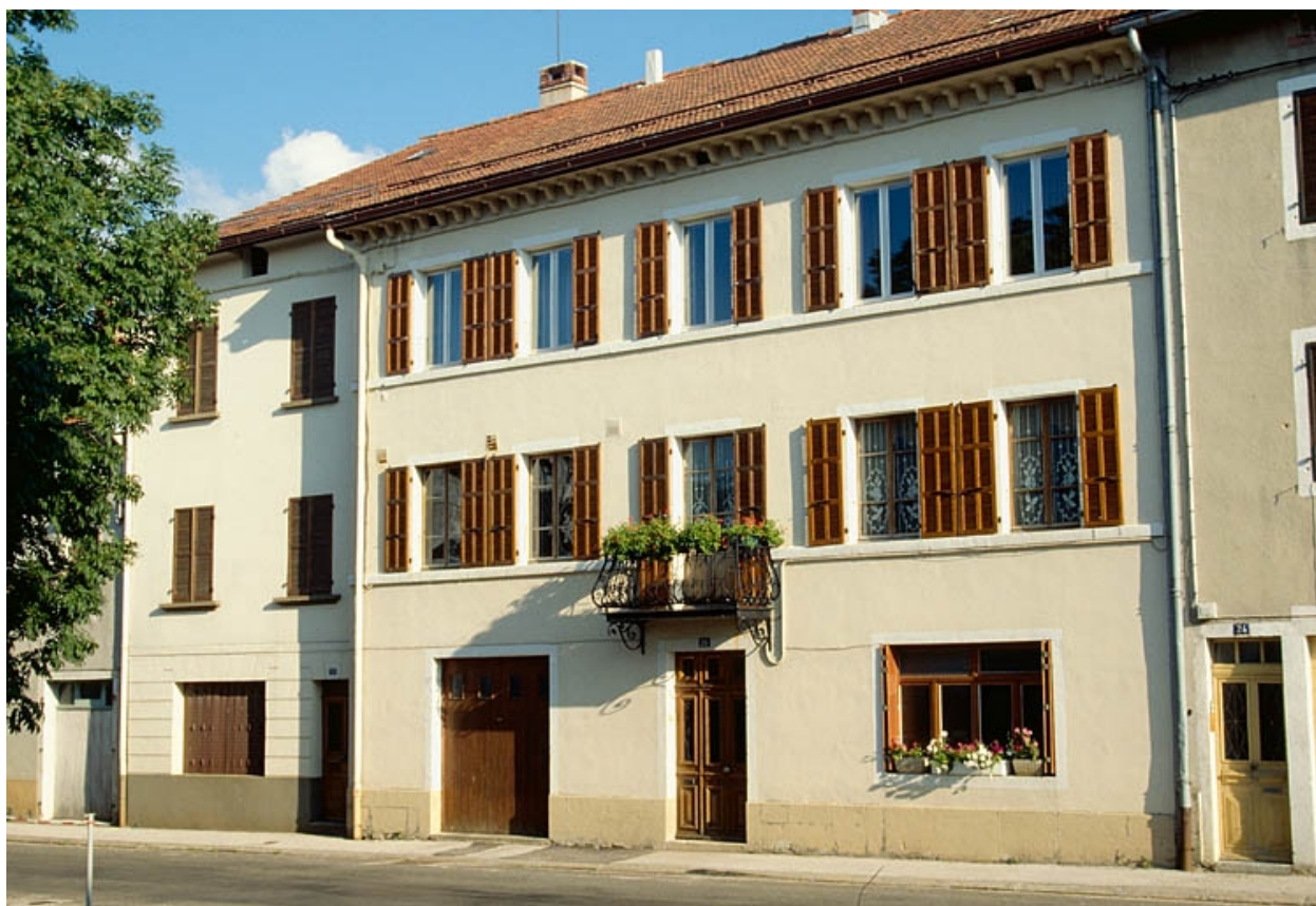
Maison, fabrique de mesures linéaires Prost-Rosset.
