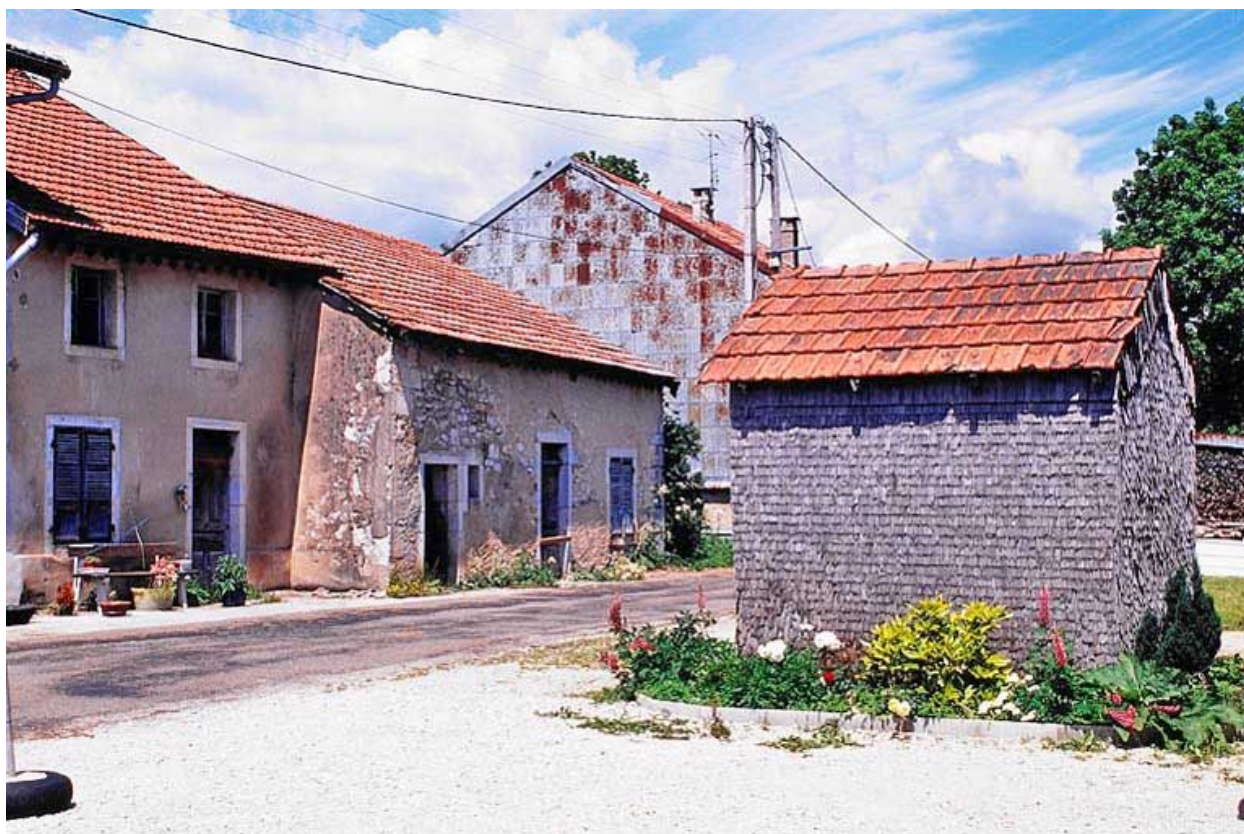
Ferme située au lieudit Orcières.
