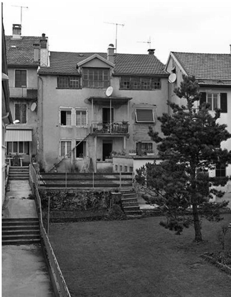
Façade postérieure d'un immeuble.
