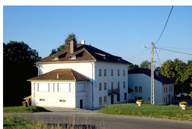
Maison, usine d'instruments de mesure, usine de lunetterie dites usine de lunetterie et fabrique de mesures linéaires Tournier Frères. Phot. Laurent Poupard IVR43_19903900598ZA
