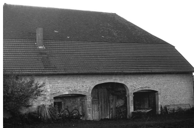
Vue du mur gouttereau droit.
