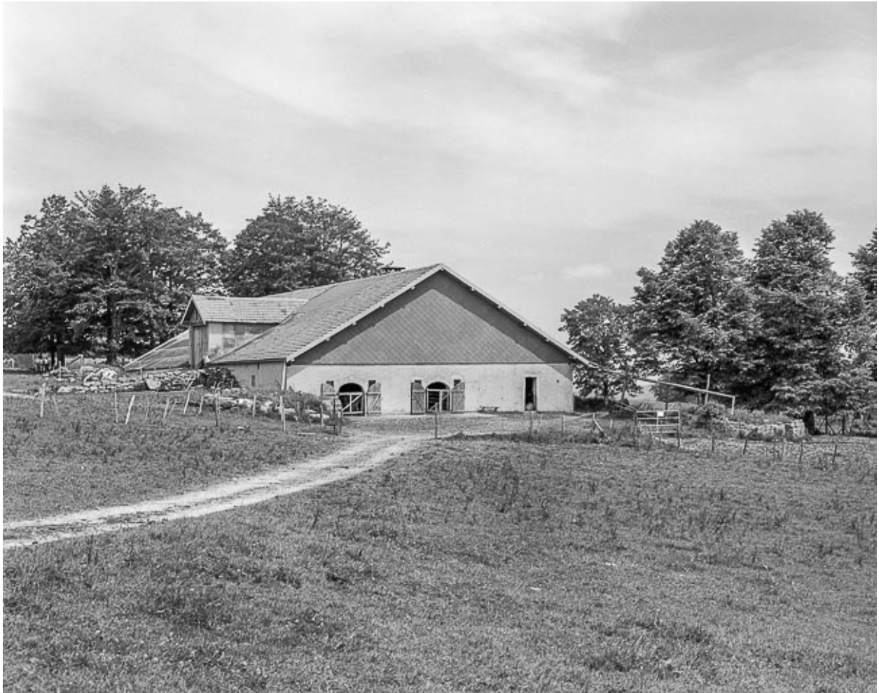
Façades postérieure et latérale gauche.
