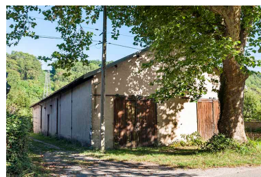
Magasin industriel vu depuis la route.
