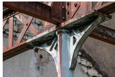
Détail de la charpente métallique.
