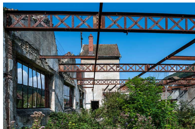
Intérieur de l'atelier de fabrication.
