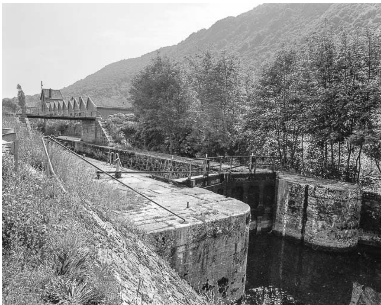
Vue de l'usine depuis l'écluse en 1976.
