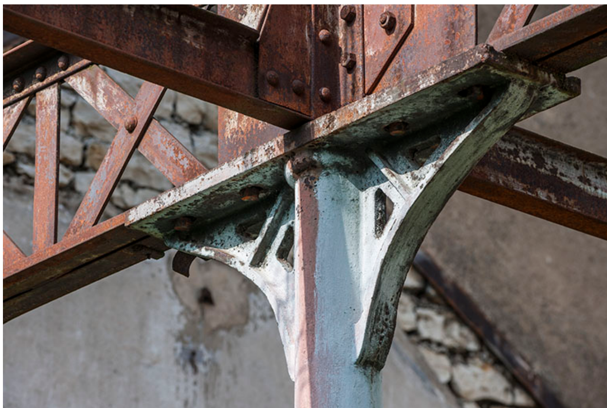
Détail de la charpente métallique.
