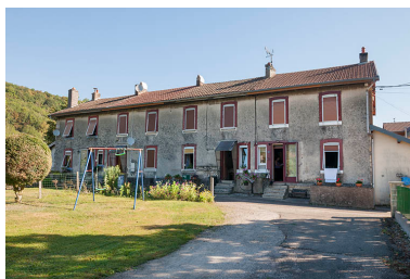
Logement ouvrier (8 appartements). Vue depuis le nord.
