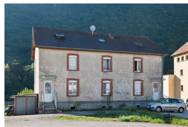
Logement ouvrier (sud) à 4 appartements. Façade ouest.
