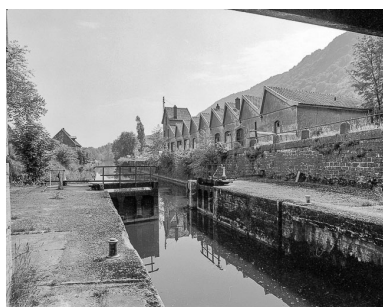
L'usine depuis le sas de l'écluse en 1976. Phot. Bernard Lardière IVR43_19762500097X
