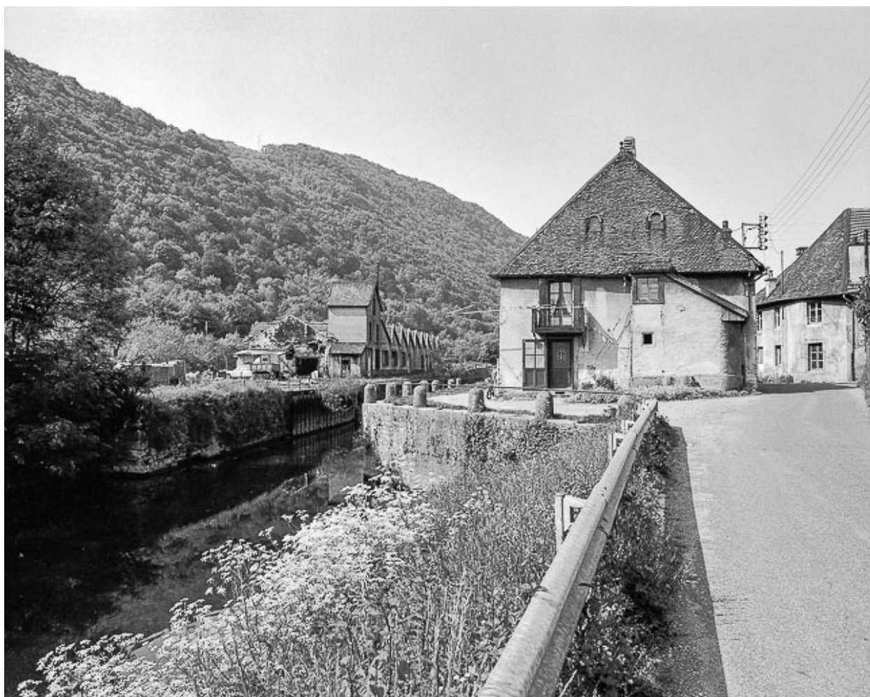
L'usine et le canal depuis le nord-est en 1976.
