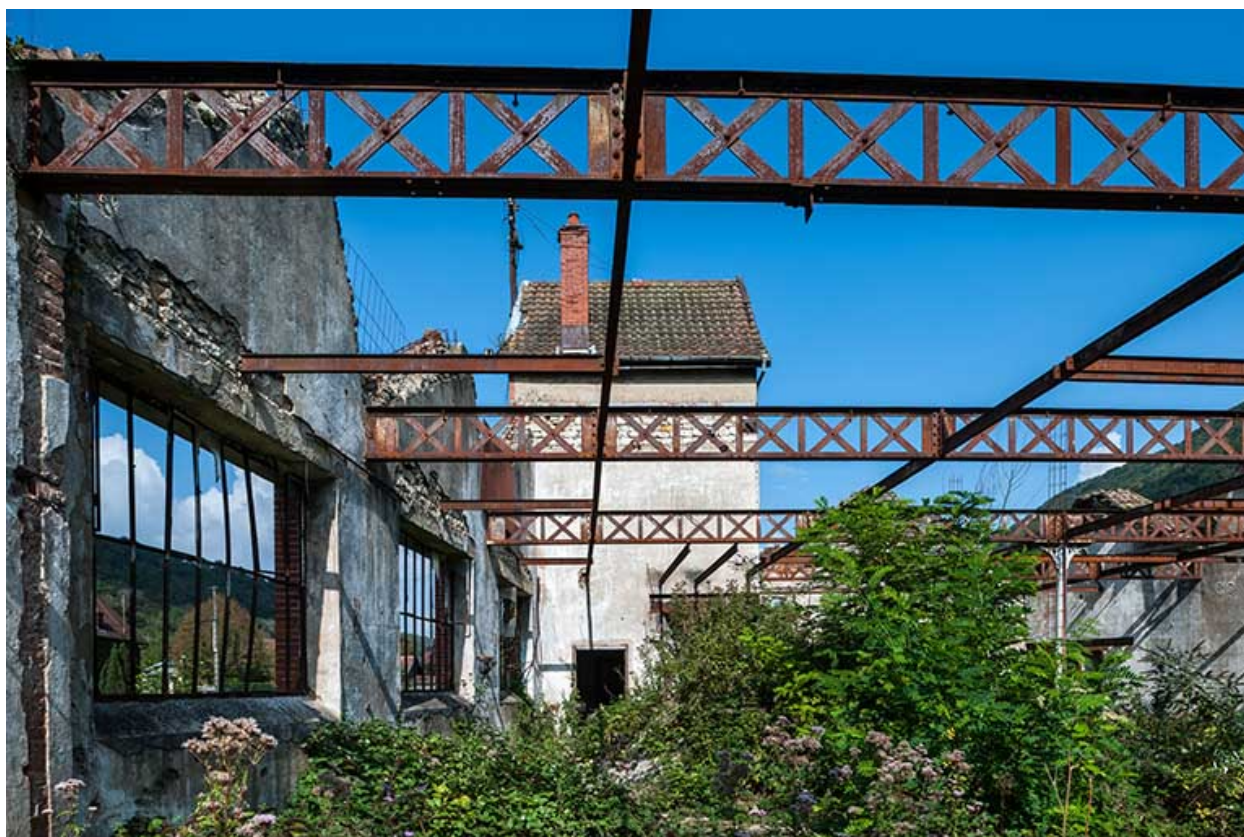
Intérieur de l'atelier de fabrication.
