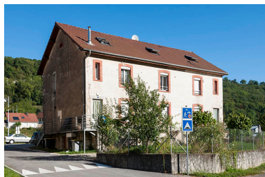
Logement ouvrier (sud) à 4 appartements. Façade est. Phot. Jérôme Mongreville IVR43_20162501147NUC4A
