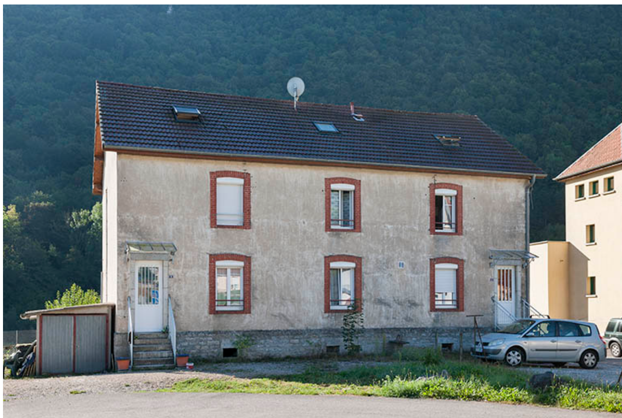
Logement ouvrier (sud) à 4 appartements. Façade ouest.
