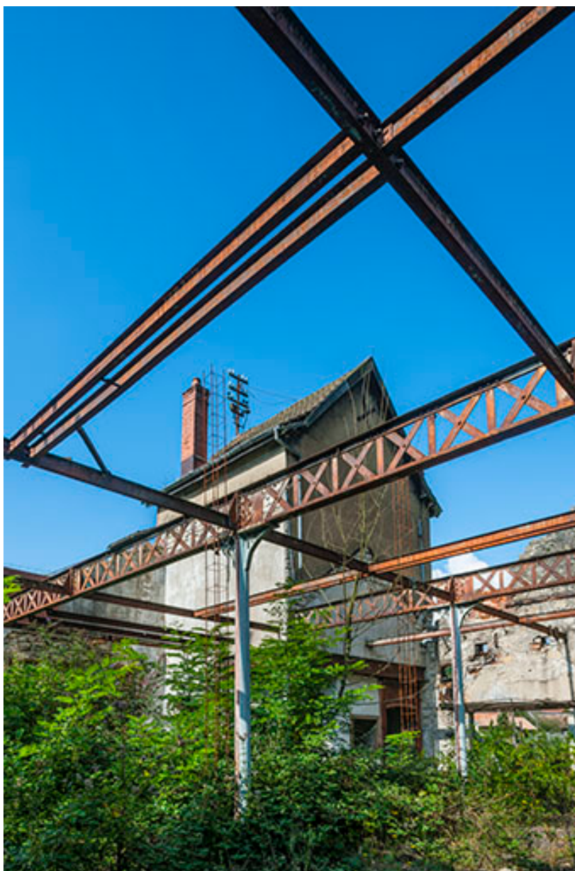
Charpente métallique de l'atelier de fabrication.
