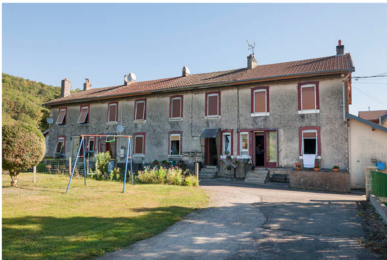
Logement ouvrier (8 appartements). Vue depuis le nord.
