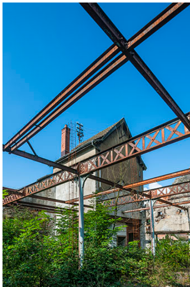
Charpente métallique de l'atelier de fabrication.
