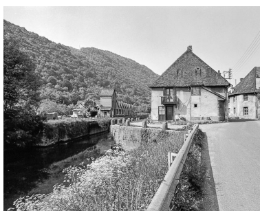
L'usine et le canal depuis le nord-est en 1976. Phot. Bernard Lardière IVR43_19762500093X
