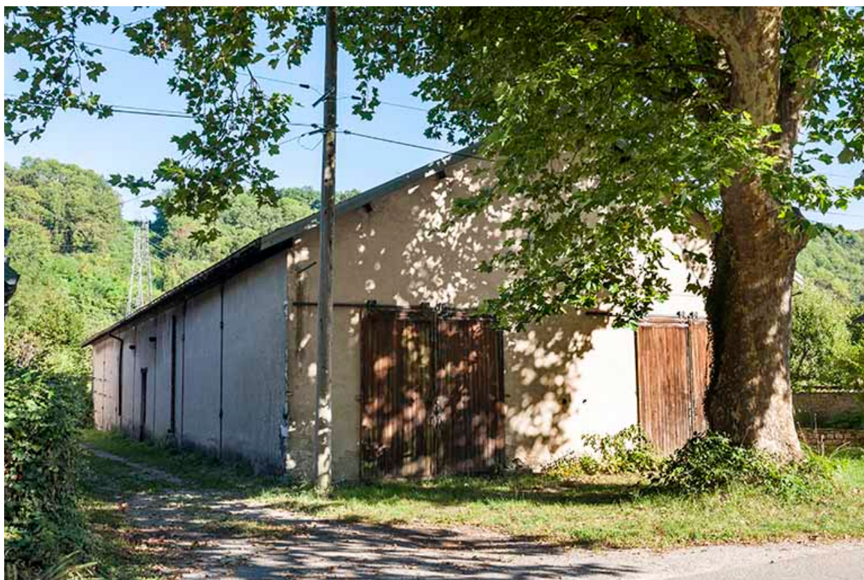
Magasin industriel vu depuis la route.
