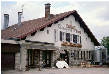
Façade antérieure. Phot. Laurent Poupard IVR43_19903900635ZA
