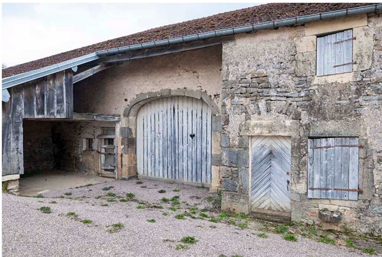
La façade principale, à trois travées.
