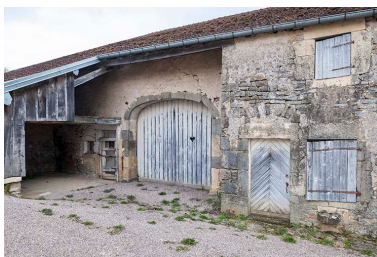
La façade principale, à trois travées. Phot. Jérôme Mongreville IVR43_20167000240NUC4A
