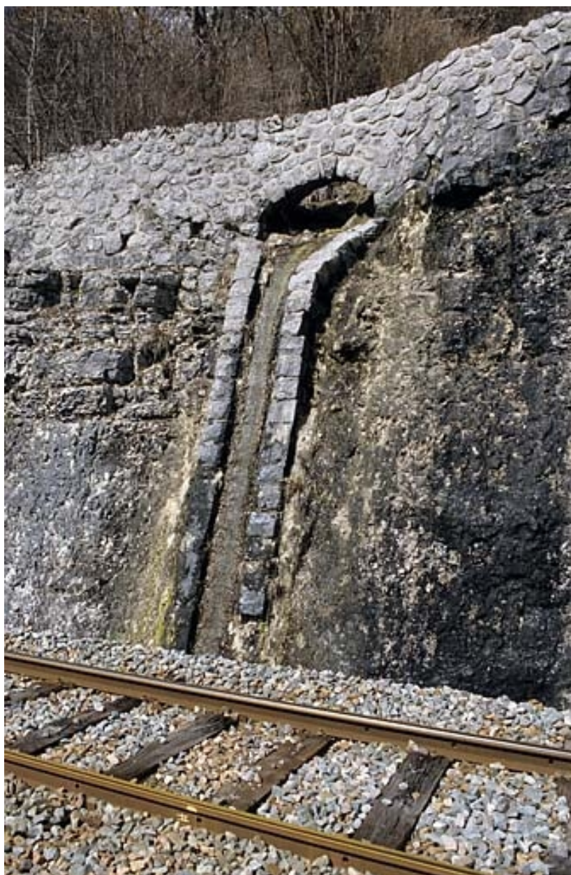
Descente d'eau dans le mur de protection à droite de la voie, de trois quarts droite.
