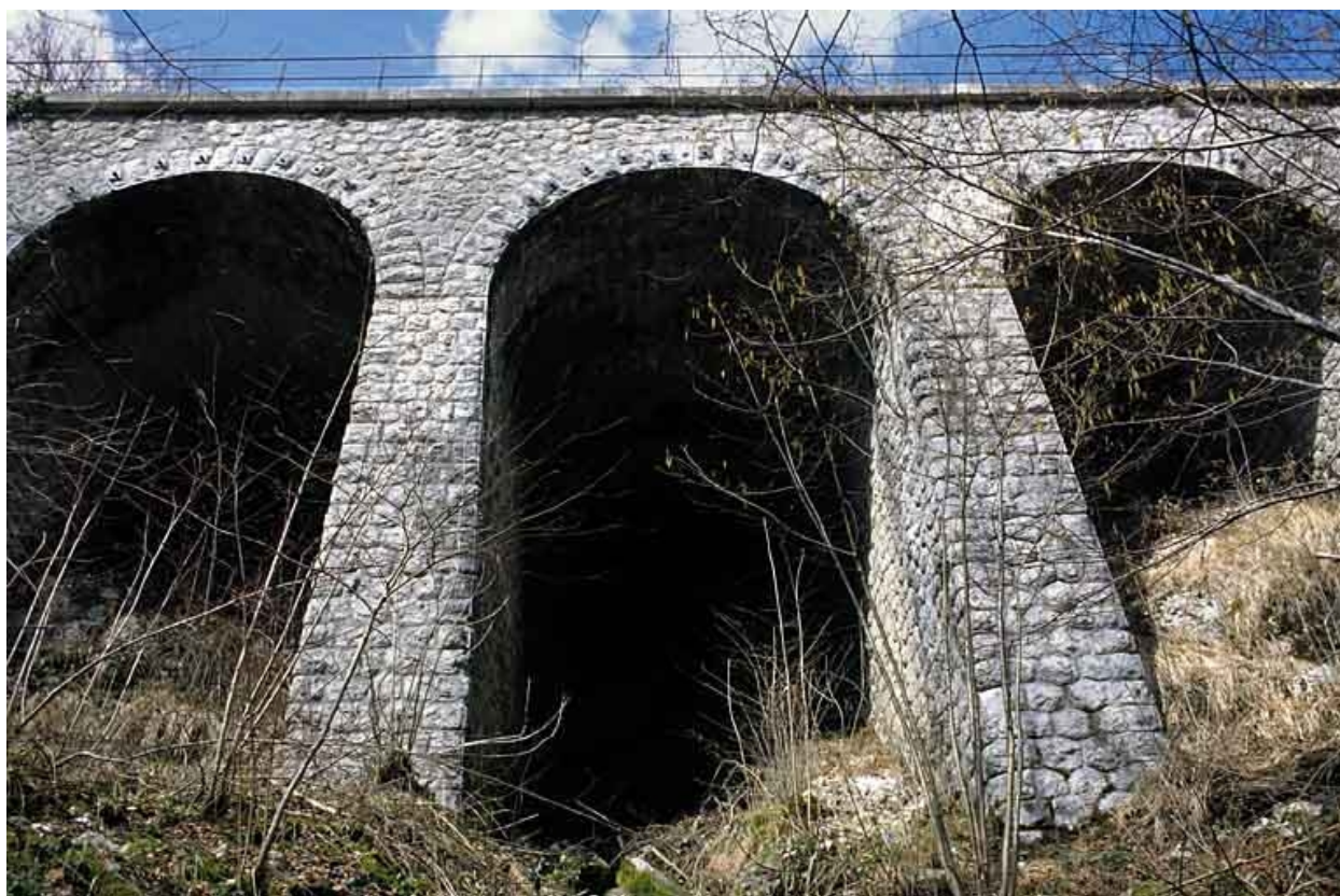
Mur de soutènement de la route : arcades.
