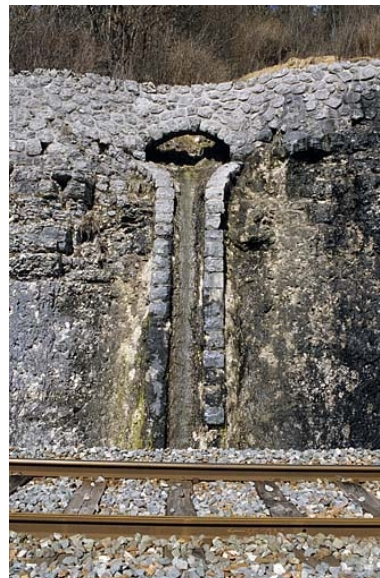
Descente d'eau dans le mur de protection à droite de la voie. Phot. Yves Sancey IVR43_20053900633ZA
