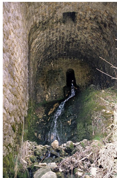
Mur de soutènement de la route : aqueduc, dans l'arche centrale. Phot. Yves Sancey IVR43_20053900631ZA
