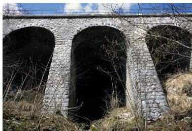
Mur de soutènement de la route : arcades. Phot. Yves Sancey IVR43_20053900630ZA
