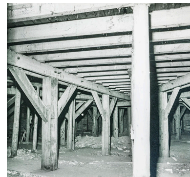
[Le Kursaal avant et pendant les travaux], 1980-1982 : [charpente supportant la piste de danse], octobre 1980. Autr. Jean-Paul Tupin IVR43_20232500511NUC2A
