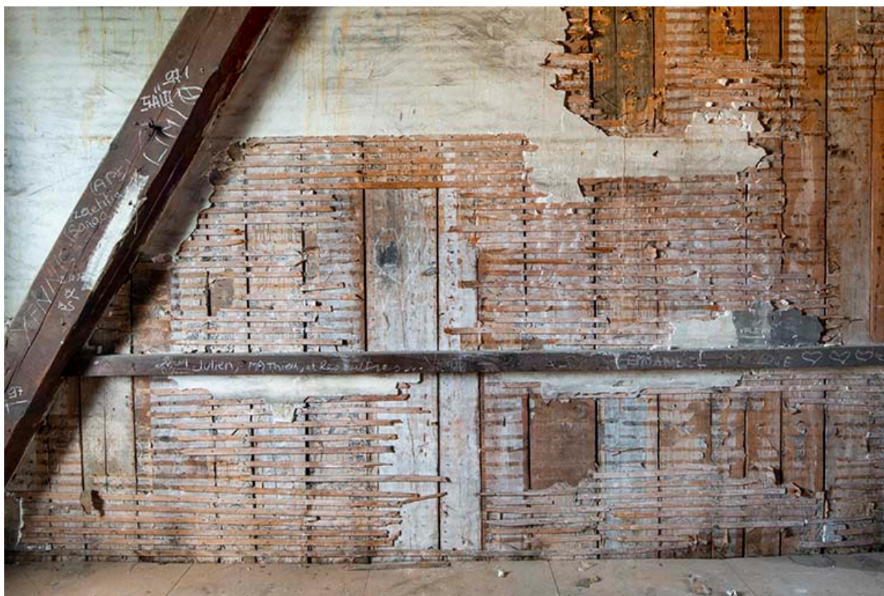
Grand Kursaal, pièce d'accès au comble : mur en planches avec lattis plâtré.
