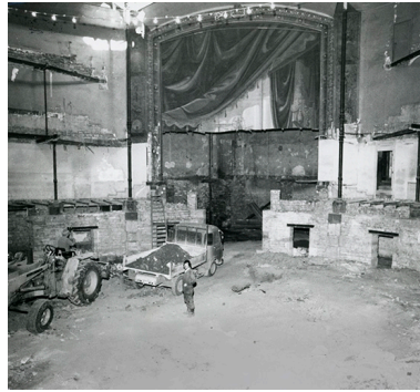
[Le Kursaal avant et pendant les travaux], 1980-1982 : [terrassment mécanique au sous-sol], février 1981.
