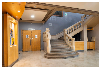
Bâtiment d'entrée, vestibule : entrée du bar et escalier desservant le 1er étage (foyer du public). Phot. Jérôme Mongreville IVR43_20232500134NUC4A
