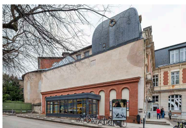
Bâtiment d'entrée : façade latérale gauche, de trois quarts droite. Phot. Jérôme Mongreville IVR43_20232500104NUC4A
