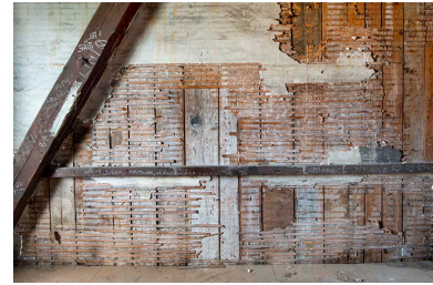
Grand Kursaal, pièce d'accès au comble, mur en planches avec lattis plâtré. Phot. Jérôme Mongreville IVR43_20232500211NUC4A
