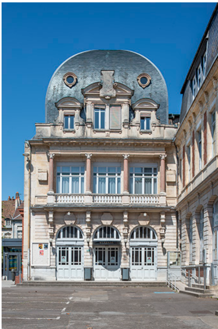
Bâtiment d'entrée : façade antérieure.
