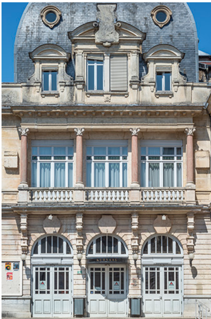
Bâtiment d'entrée, façade antérieure (vue resserrée).
