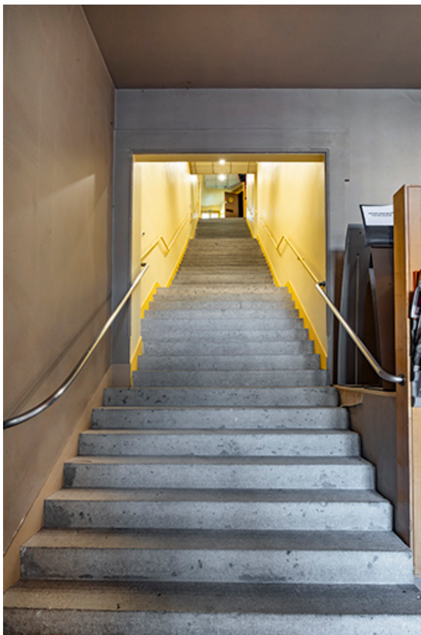
Bâtiment d'entrée, vestibule : escalier desservant les balcons.
