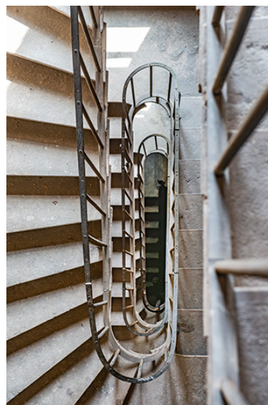
Bâtiment Proudhon : escalier secondaire (corps hors-oeuvre à l'est). Phot. Jérôme Mongreville IVR43_20232500220NUC4A
