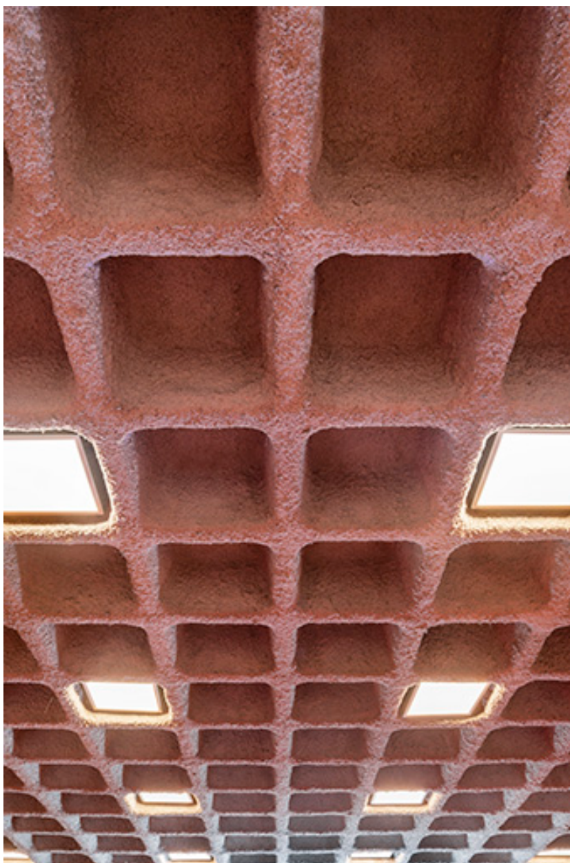
Petit Kursaal, salle : plafond à caissons.
