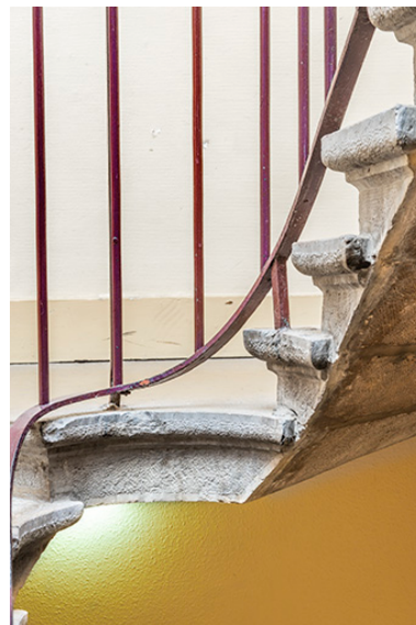
Bâtiment d'entrée : extrémité des marches de l'escalier de l'administration au niveau d'un repos. Phot. Jérôme Mongreville IVR43_20232500225NUC4A
