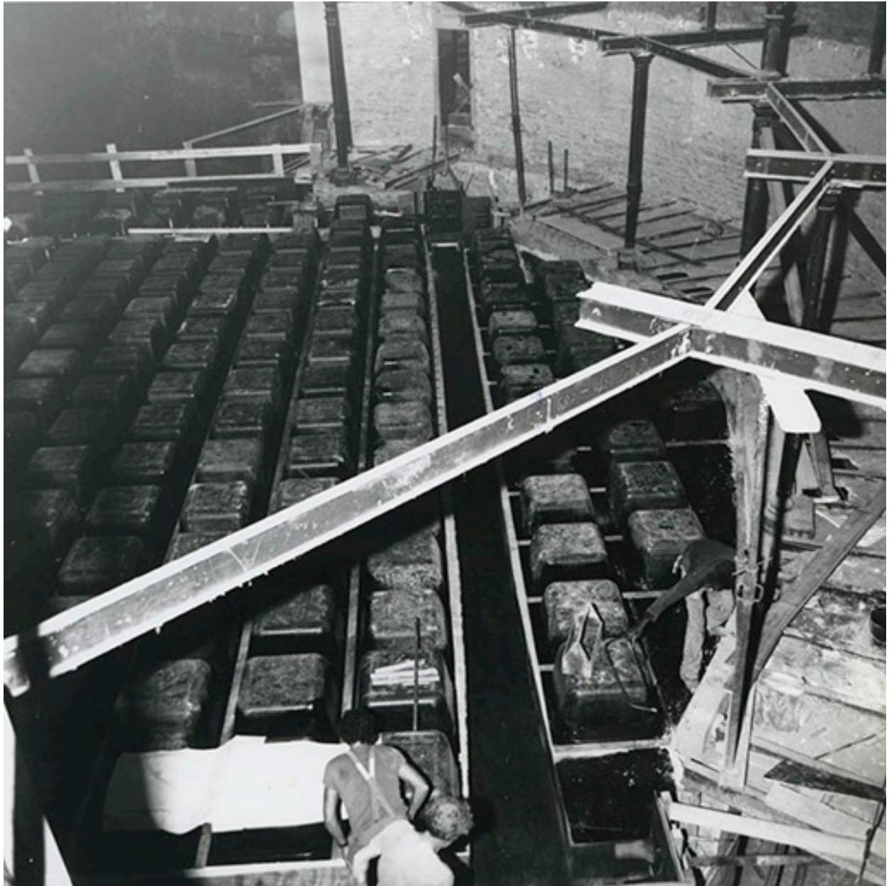
[Le Kursaal avant et pendant les travaux], 1980-1982 : coffrage de la dalle et mise en tension, août 1981.
