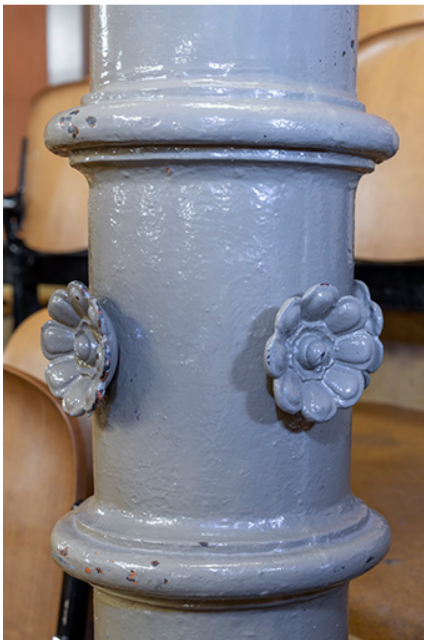
Grand Kursaal, salle : décor d'une colonne en fonte.
