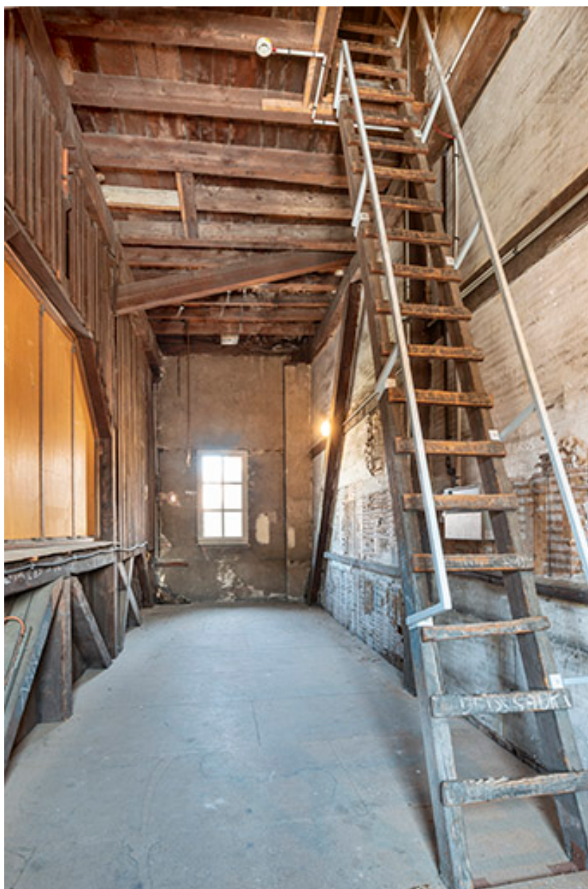
Grand Kursaal : pièce d'accès au comble. Lunette de la fausse-coupole à gauche et escalier desservant le comble à droite.
