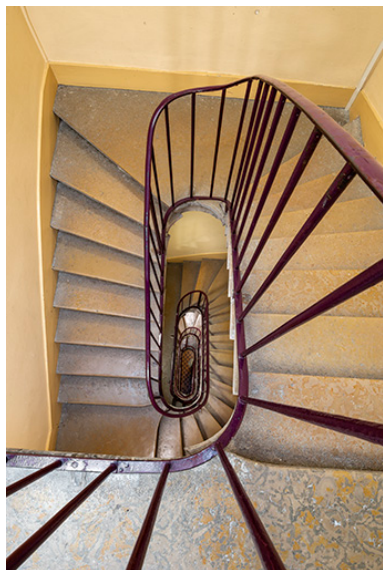
Bâtiment d'entrée : escalier de l'administration. Phot. Jérôme Mongreville IVR43_20232500223NUC4A
