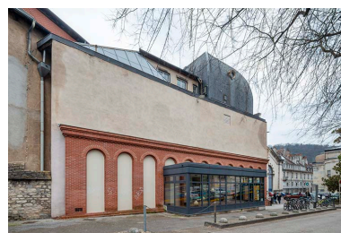
Bâtiment d'entrée : façade latérale gauche, de trois quarts gauche. Phot. Jérôme Mongreville IVR43_20232500105NUC4A
