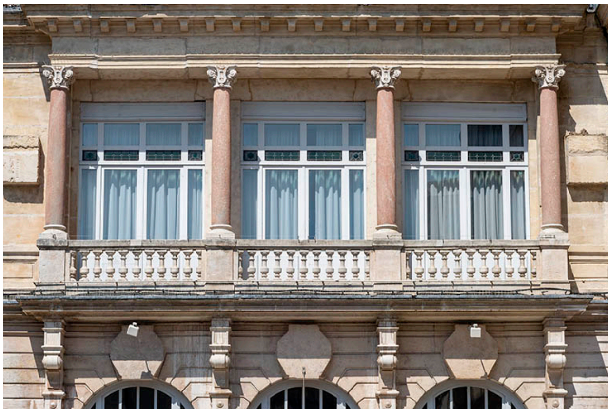
Bâtiment d'entrée, façade antérieure : 1er étage.
