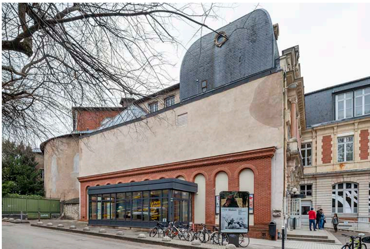
Bâtiment d'entrée : façade latérale gauche, de trois quarts droite.
