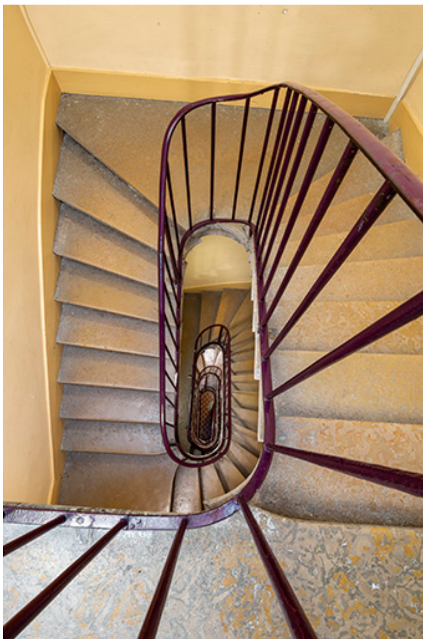
Bâtiment d'entrée : escalier de l'administration.
