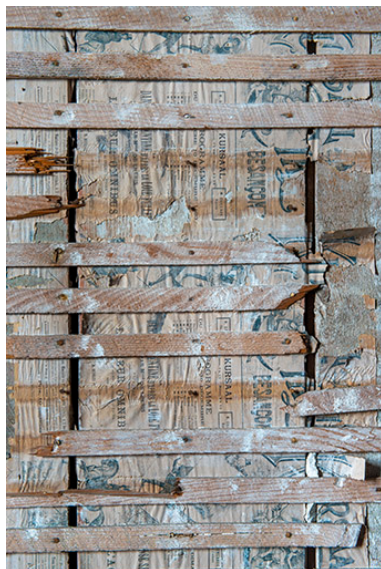
Grand Kursaal, pièce d'accès au comble : lattis recouvrant un programme de 1893 utilisé comme isolant. Phot. Jérôme Mongreville IVR43_20232500212NUC4A
