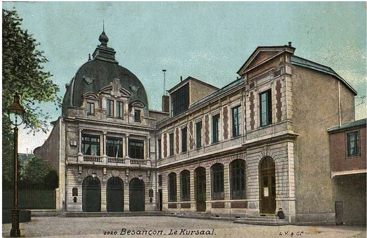
2920. Besançon - Le Kursaal. [1er quart 20e siècle, avant 1914].
