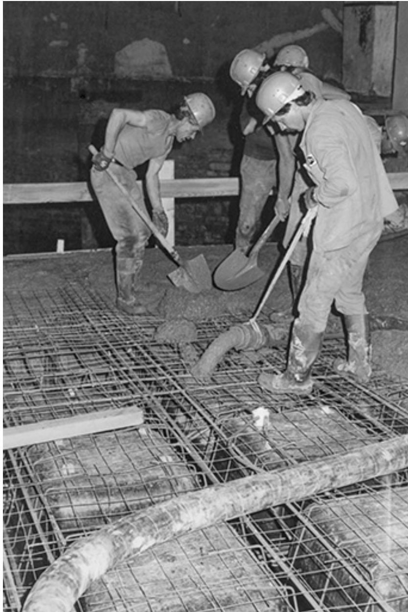
[Le Kursaal avant et pendant les travaux], 1980-1982 : coulage de la dalle, 1981.
