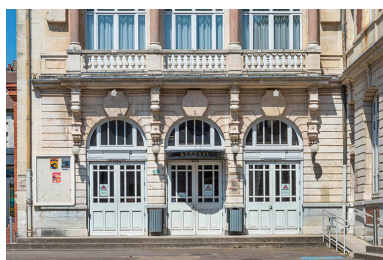
Bâtiment d'entrée, façade antérieure : rez-de-chaussée. Phot. Jérôme Mongreville IVR43_20232500117NUC4A
