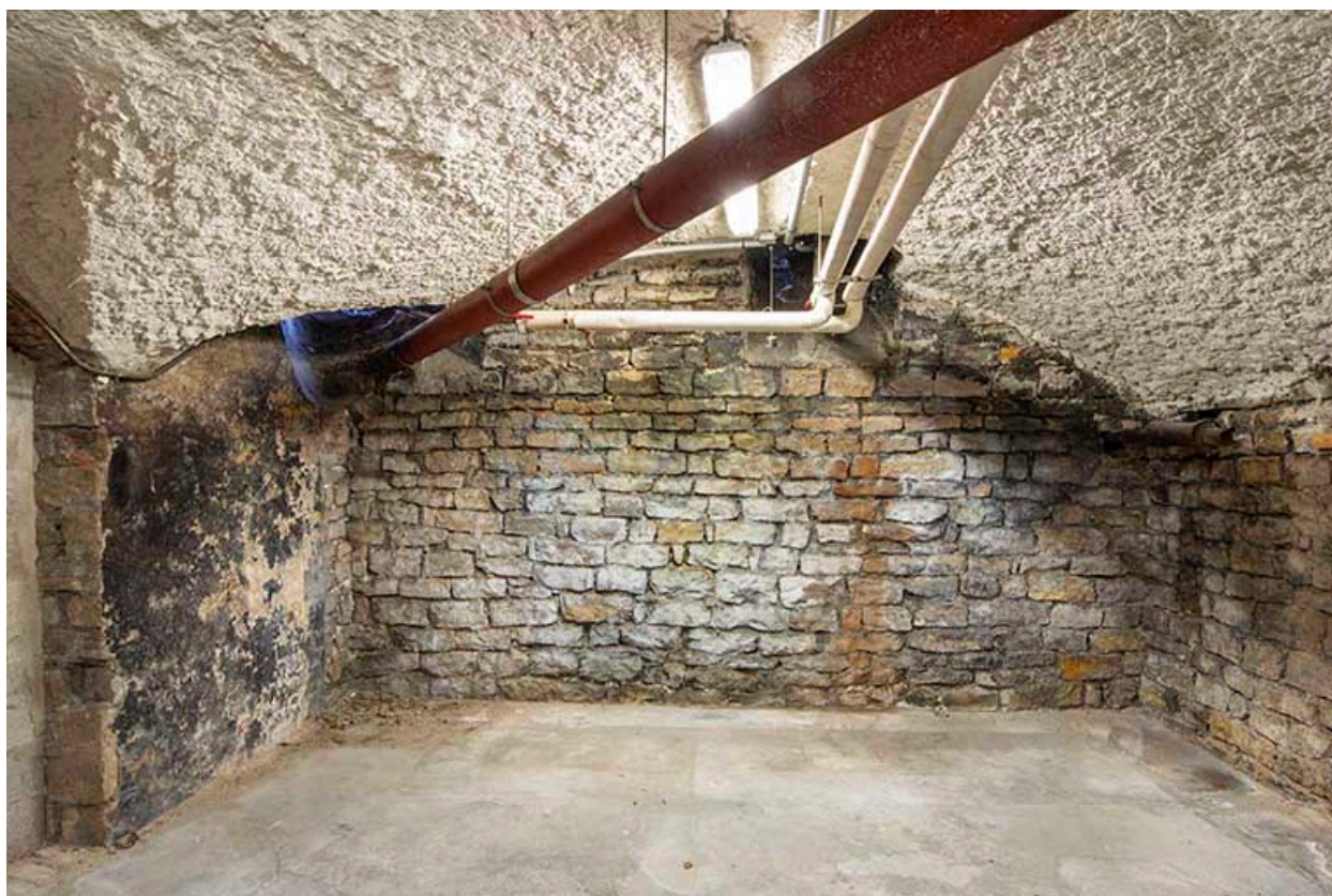
Bâtiment Proudhon : une salle voûtée au sous-sol.
