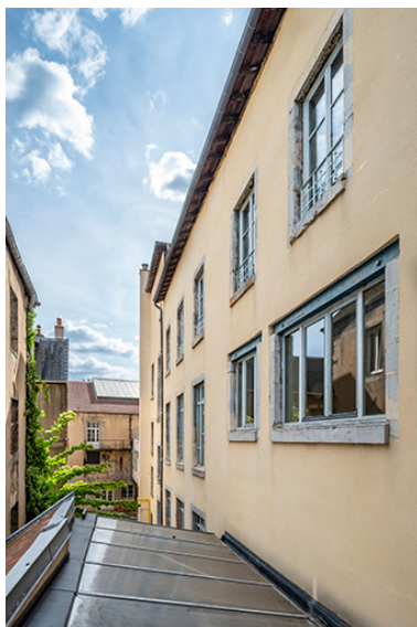
Bâtiment d'entrée : façade latérale droite, vue en enfilade. Phot. Jérôme Mongreville IVR43_20232500110NUC4A
