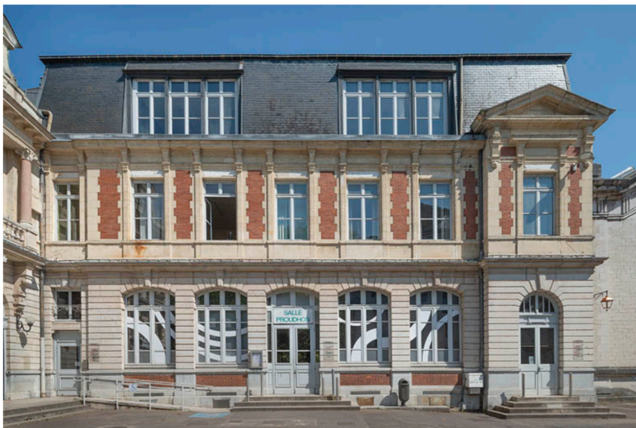
Ancienne brasserie (bâtiment Proudhon) : façade antérieure.
