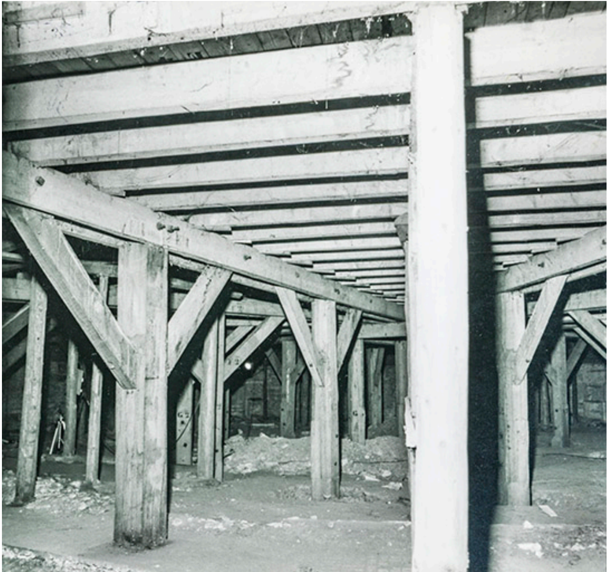
[Le Kursaal avant et pendant les travaux], 1980-1982 : [charpente supportant la piste de danse], octobre 1980.
