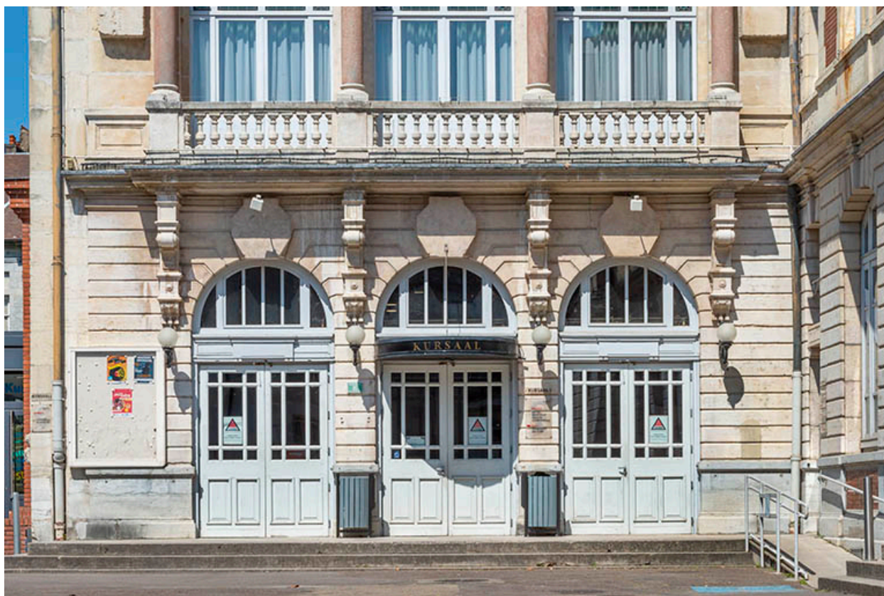
Bâtiment d'entrée, façade antérieure : rez-de-chaussée.
