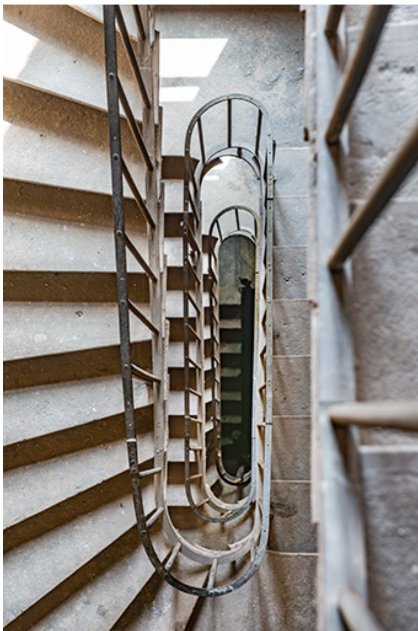
Bâtiment Proudhon : escalier secondaire (corps hors-oeuvre à l'est).
