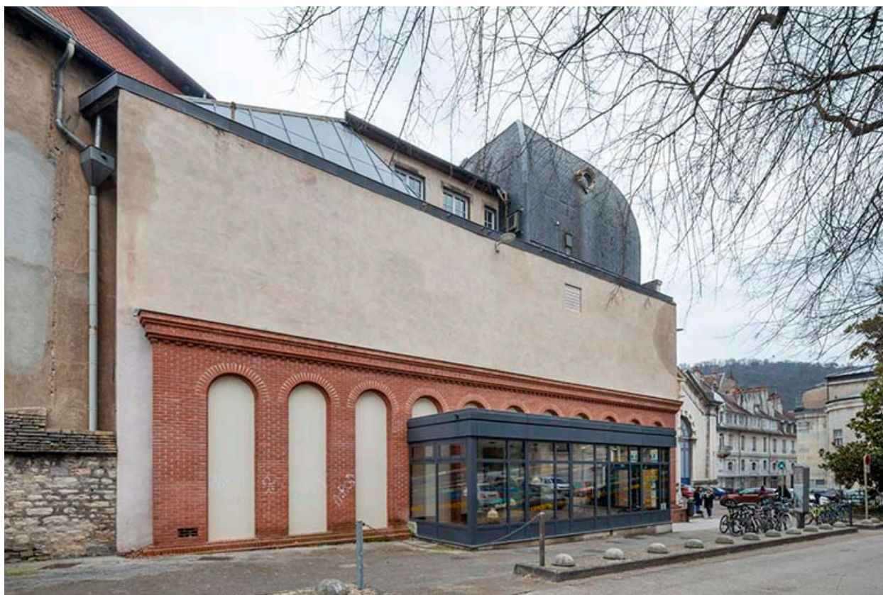
Bâtiment d'entrée : façade latérale gauche, de trois quarts gauche.
