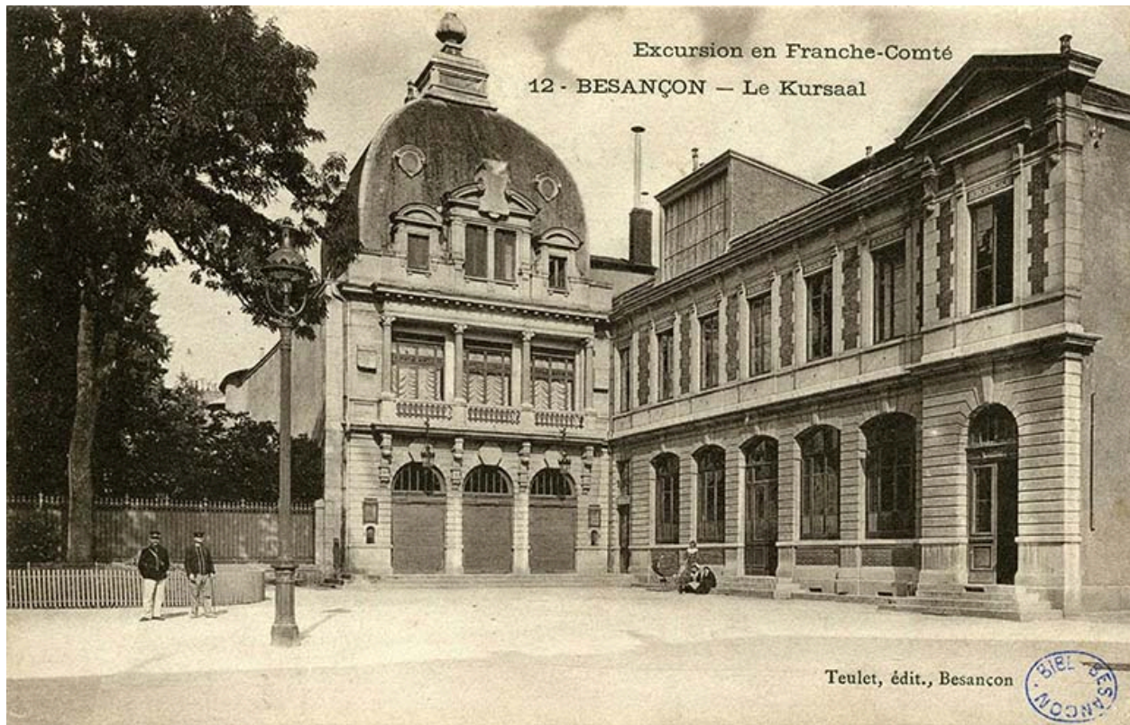
12 - Besançon - Le Kursaal. [1er quart 20e siècle, avant 1908].
