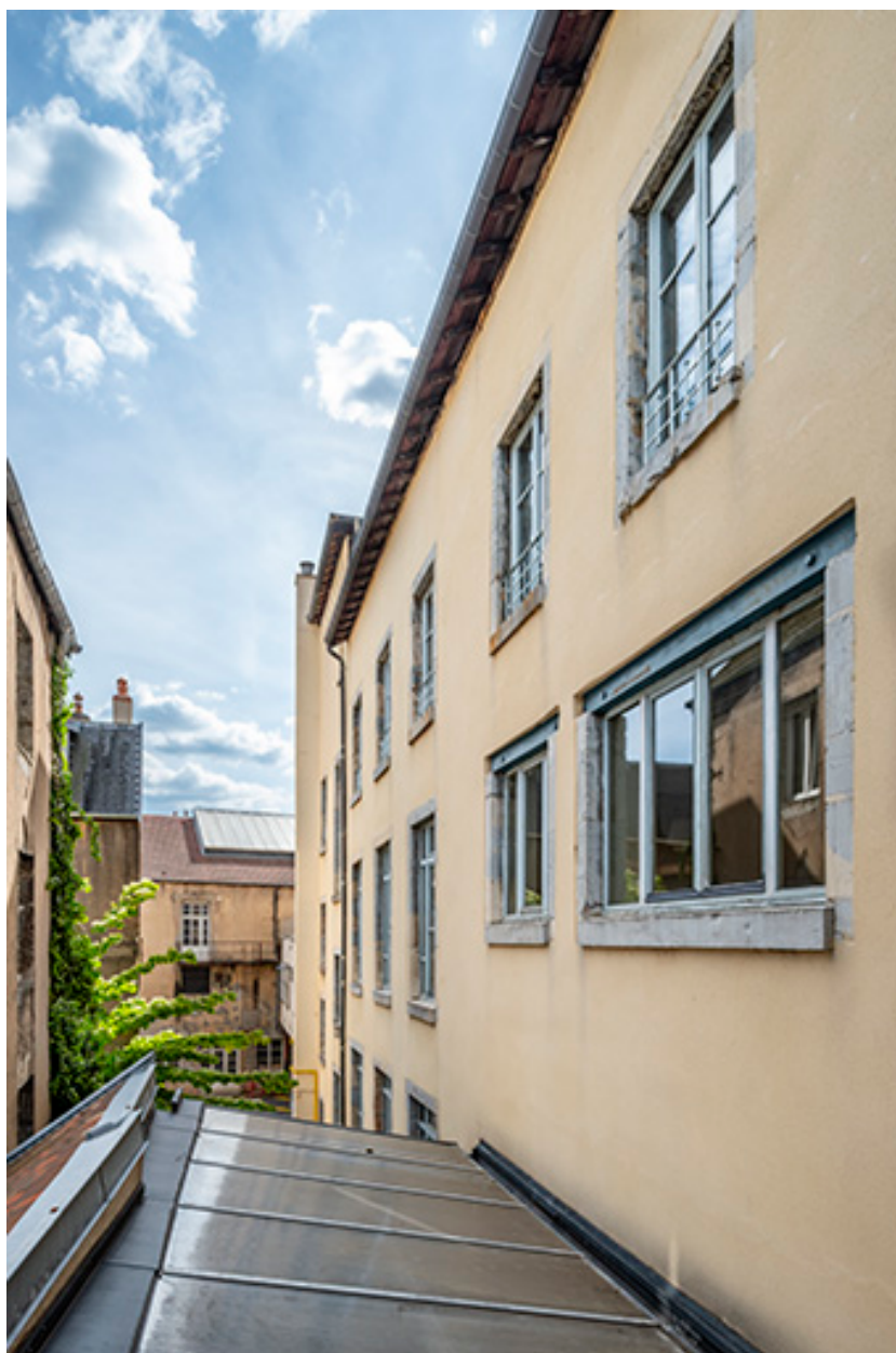
Bâtiment d'entrée : façade latérale droite, vue en enfilade.
