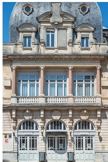
Bâtiment d'entrée, façade antérieure (vue resserrée). Phot. Jérôme Mongreville IVR43_20232500118NUC4A
