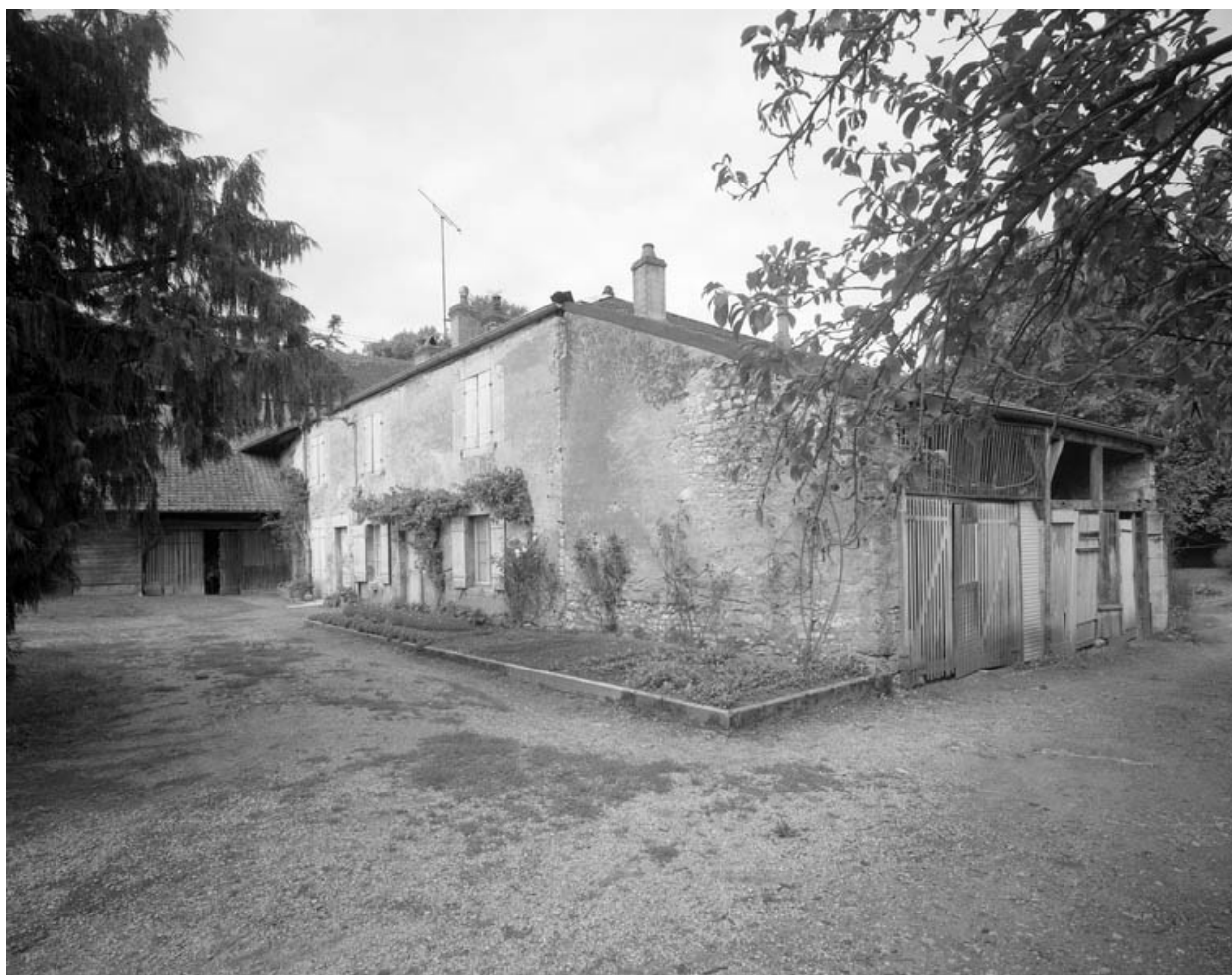
Logement annexe au fond du parc.
