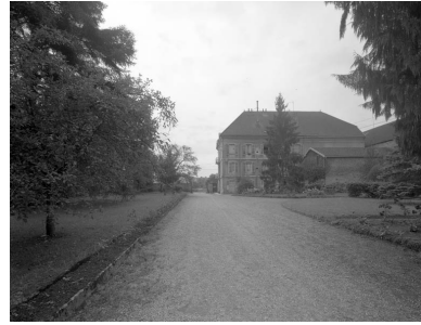
Façade postérieure depuis le fond du parc. Phot. Yves Sancey IVR43_19887000180V
