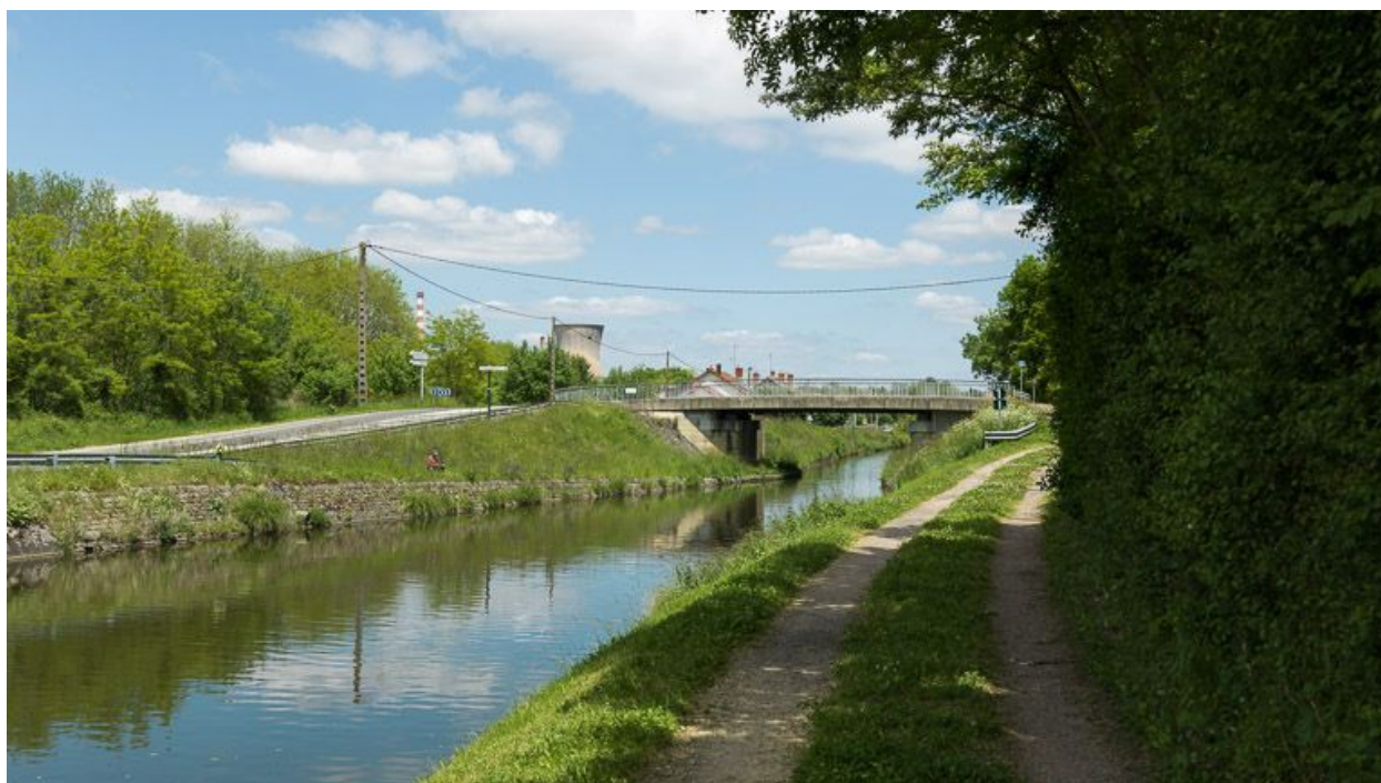
Vue d'ensemble du pont.
