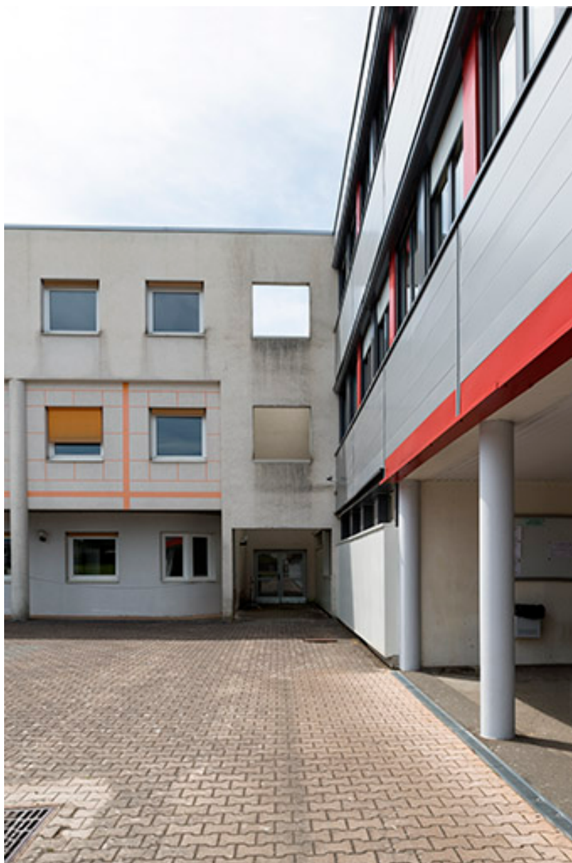
Angle intérieur nord-ouest de la cour.
