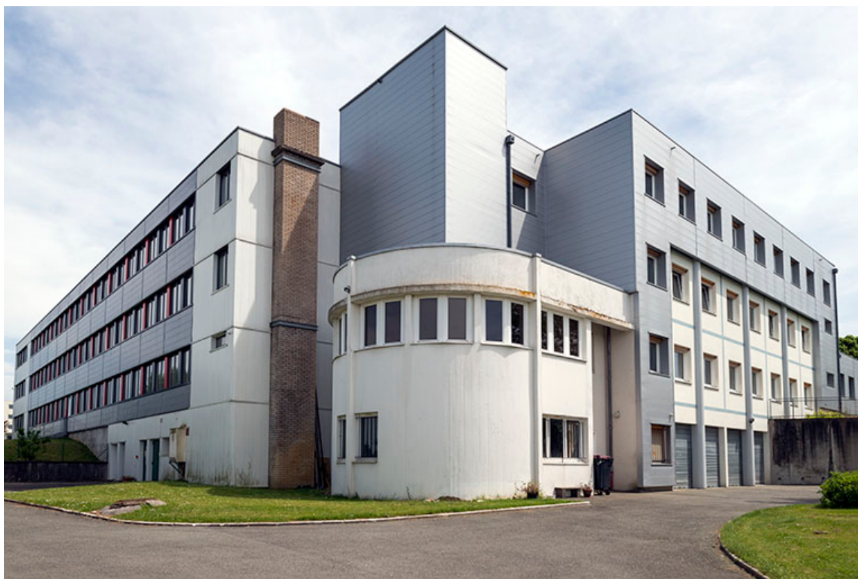
Angle extérieur nord-ouest des externats (cafétéria).
