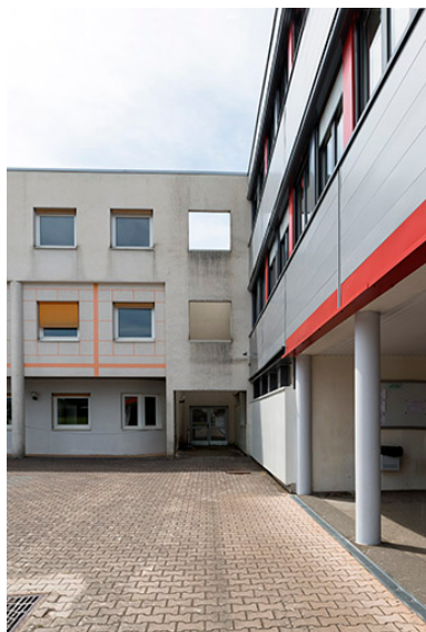
Angle intérieur nord-ouest de la cour. Phot. Mary Ruffinoni IVR43_20142500543NUC4A
