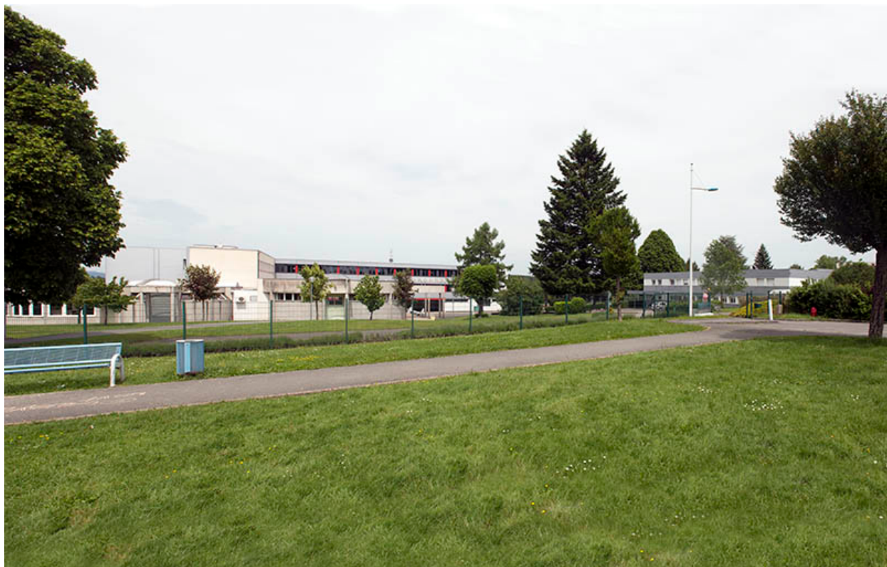
Vue d'ensemble depuis la placette au sud.
