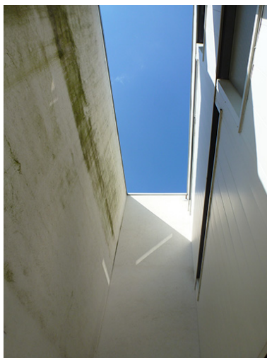
Détail architectural à la jonction des externats. Phot. Philippe Mairot IVR43_20142500557NUC4A
