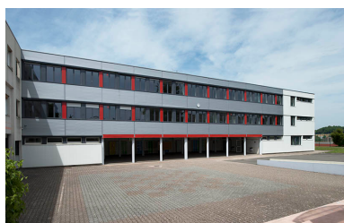
La cour, l'externat nord et le préau. Phot. Mary Ruffinoni IVR43_20142500558NUC4A
