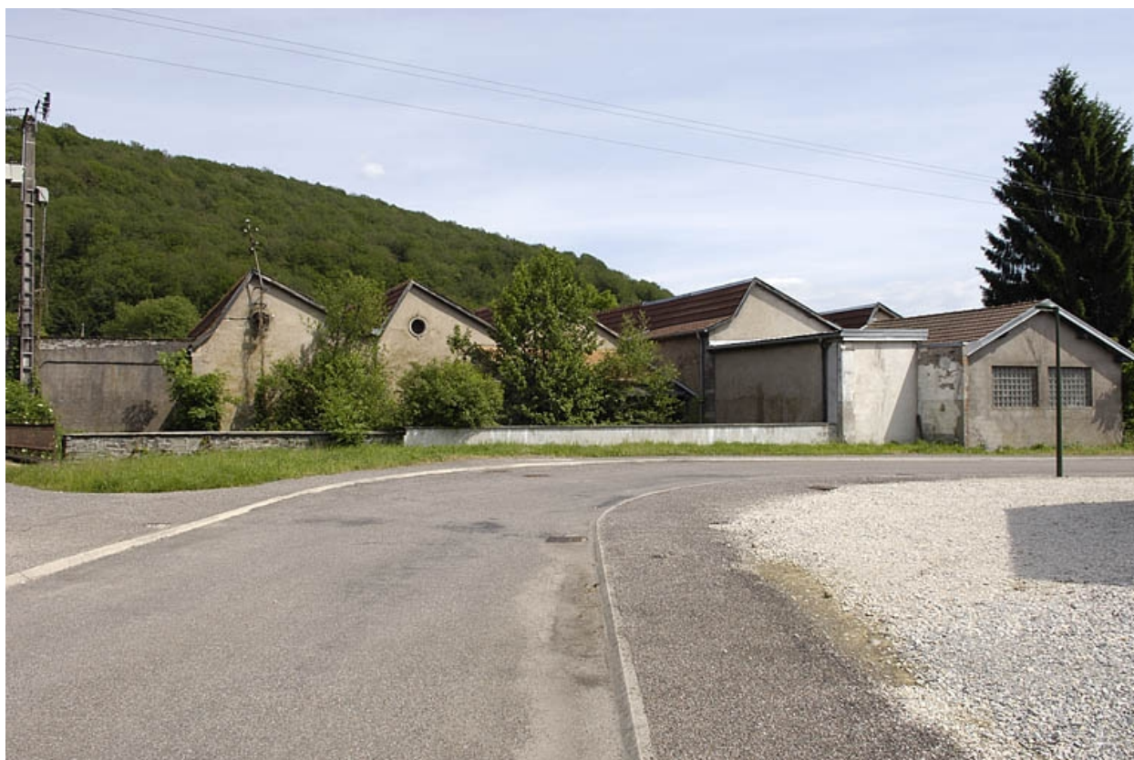
Atelier de fabrication vu depuis l'ouest.
