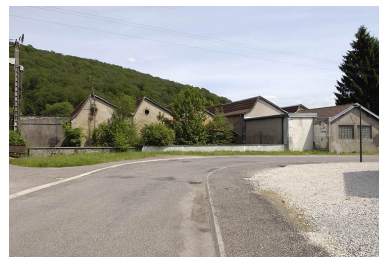
Atelier de fabrication vu depuis l'ouest. Phot. Jérôme Mongreville IVR43_20057000366NUCA
