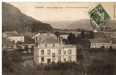
Raddon - Château Desgranges. - Vue prise du Grand-Murger. Phot. Jérôme Mongreville, Autr. Henry IVR43_20057000603NUCA
