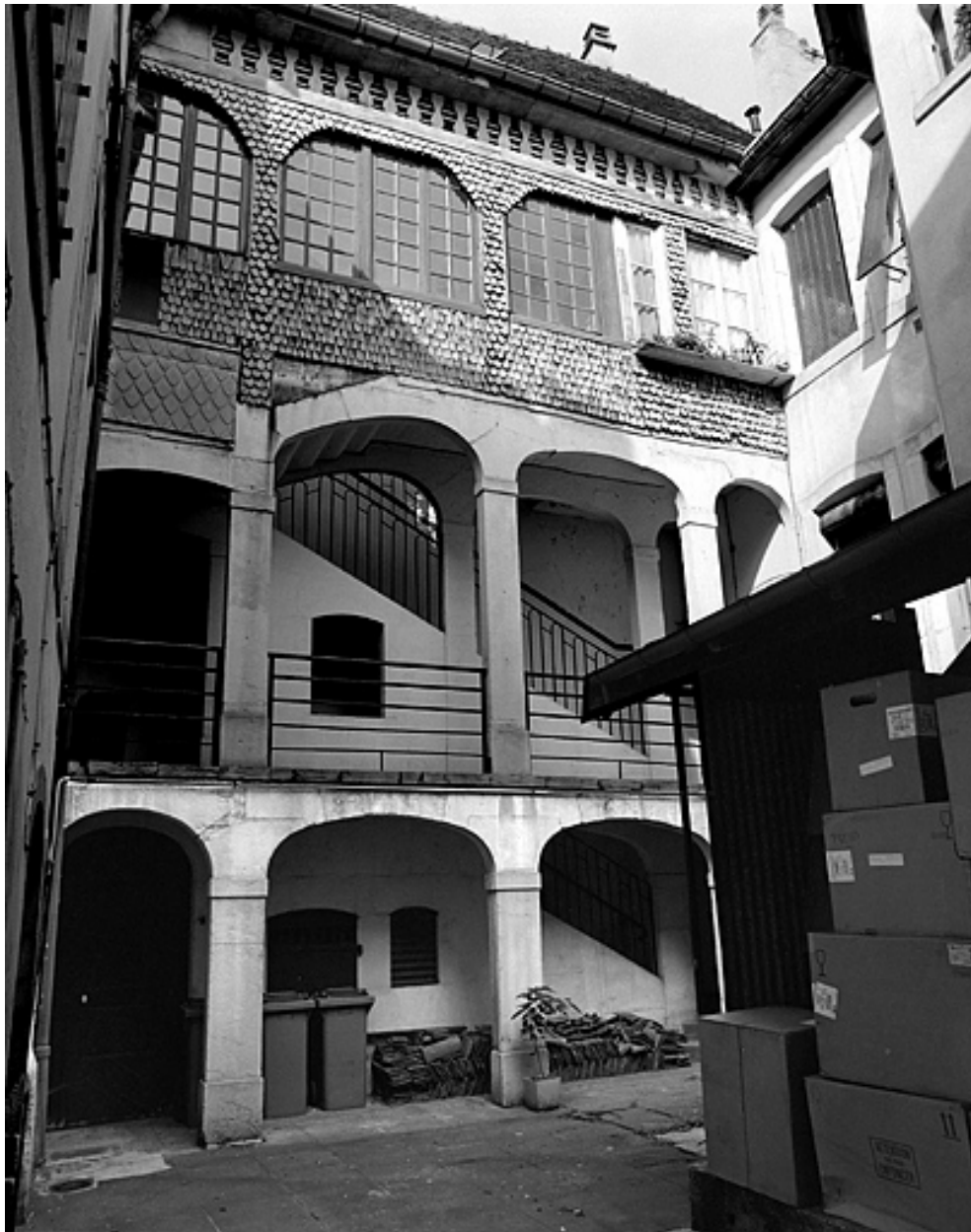
Escalier dans la cour, vue d'ensemble.
