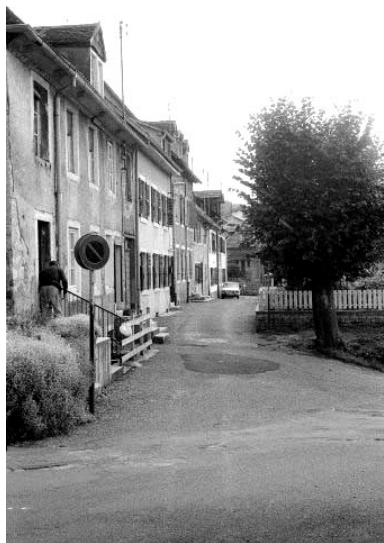
Ensemble de l'alignement. Phot. Bernard Lardière IVR43_19829000131Z
