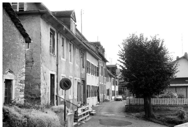
Ensemble de l'alignement. Phot. Bernard Lardière IVR43_19829000130Z
