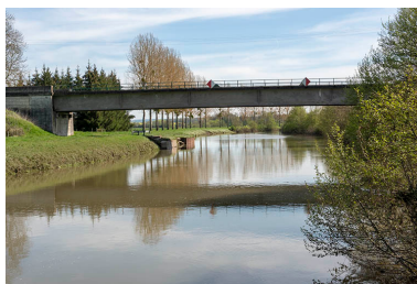
Vue sur le pont de la d partementale 46 franchissant la Sa ne. Vue vers l'amont. Phot. Sonia Dourlot IVR43_20167001878NUC4A
