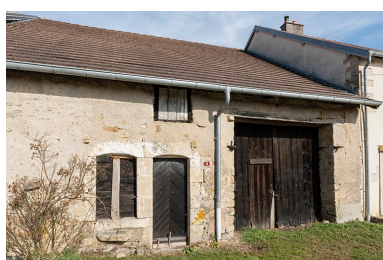
Façade de ferme à linteaux délaardés, 9 route de Vénisey. (Départementale 46) Phot. Sonia Dourlot IVR43_20197000244NUC4A
