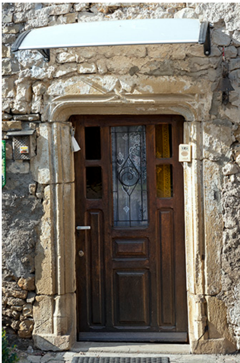
Ferme à l'ouest de l'ancienne cure (parcelles cadastrées D 562 et 446) : vue rapprochée de la porte à piédroits moulurés. (remploi?)
