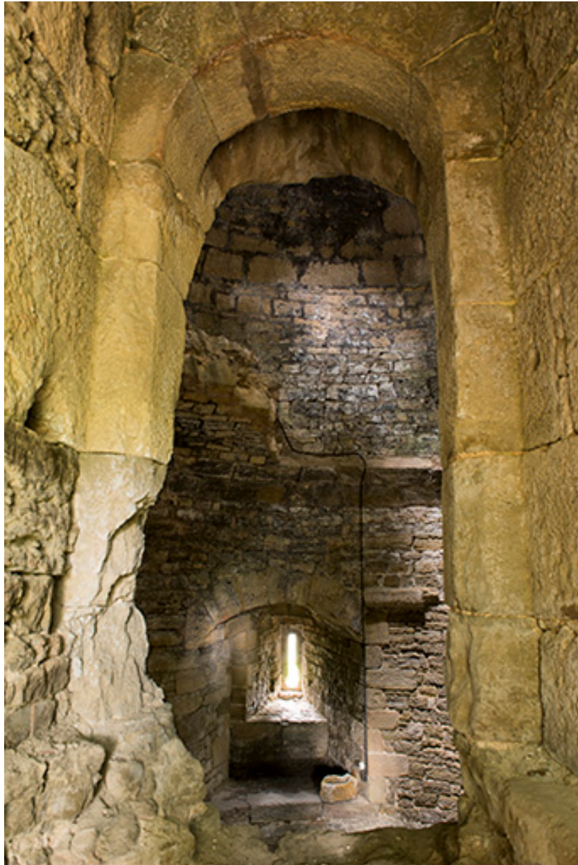
La tour ouest. Vue intérieure depuis l'entrée.
