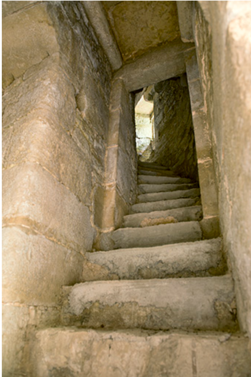
La tour ouest. Vue intérieure de l'escalier.
