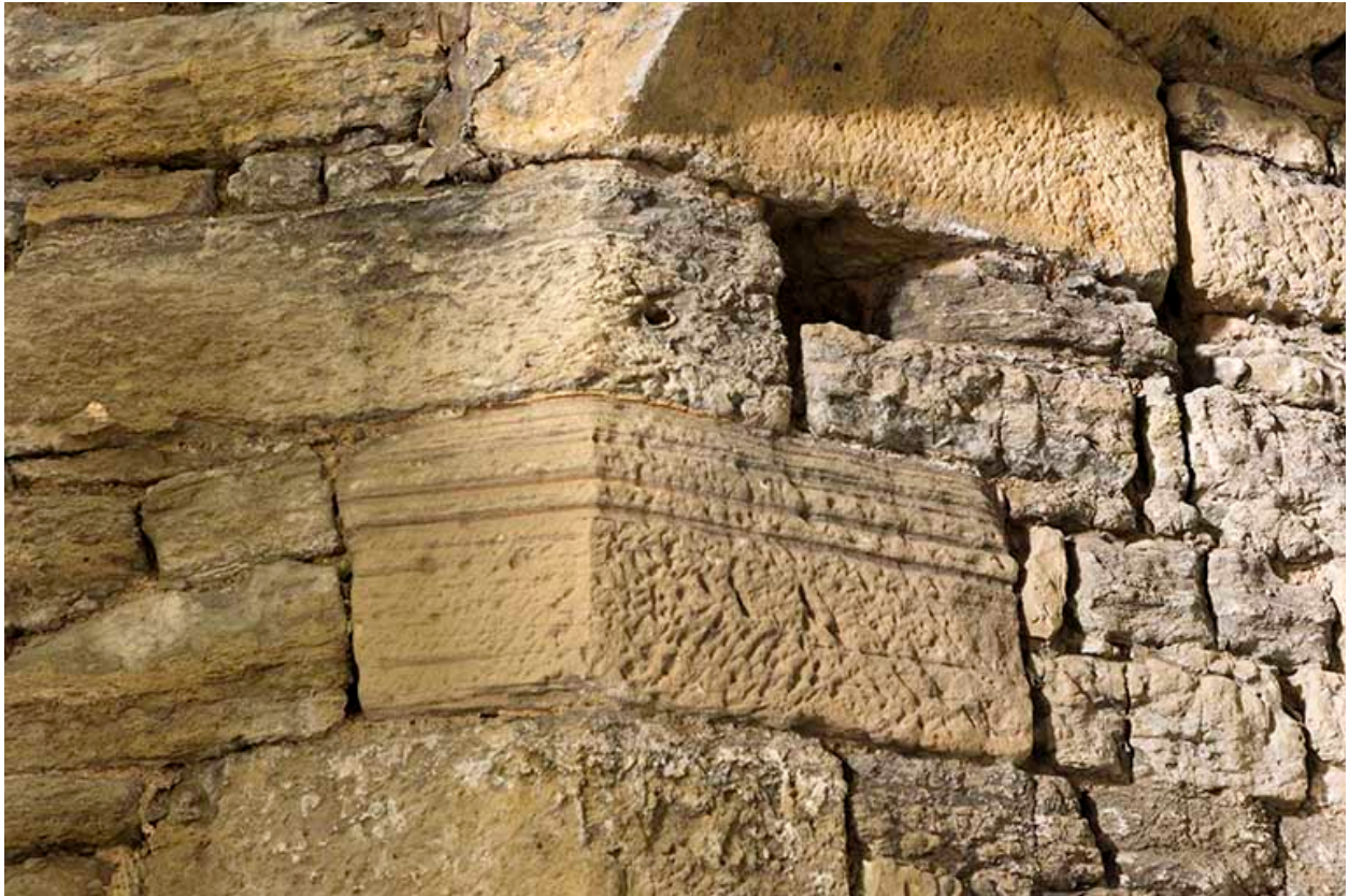
Détail de maçonnerie.
