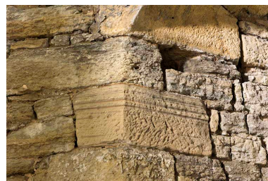
Détail de maçonnerie.
