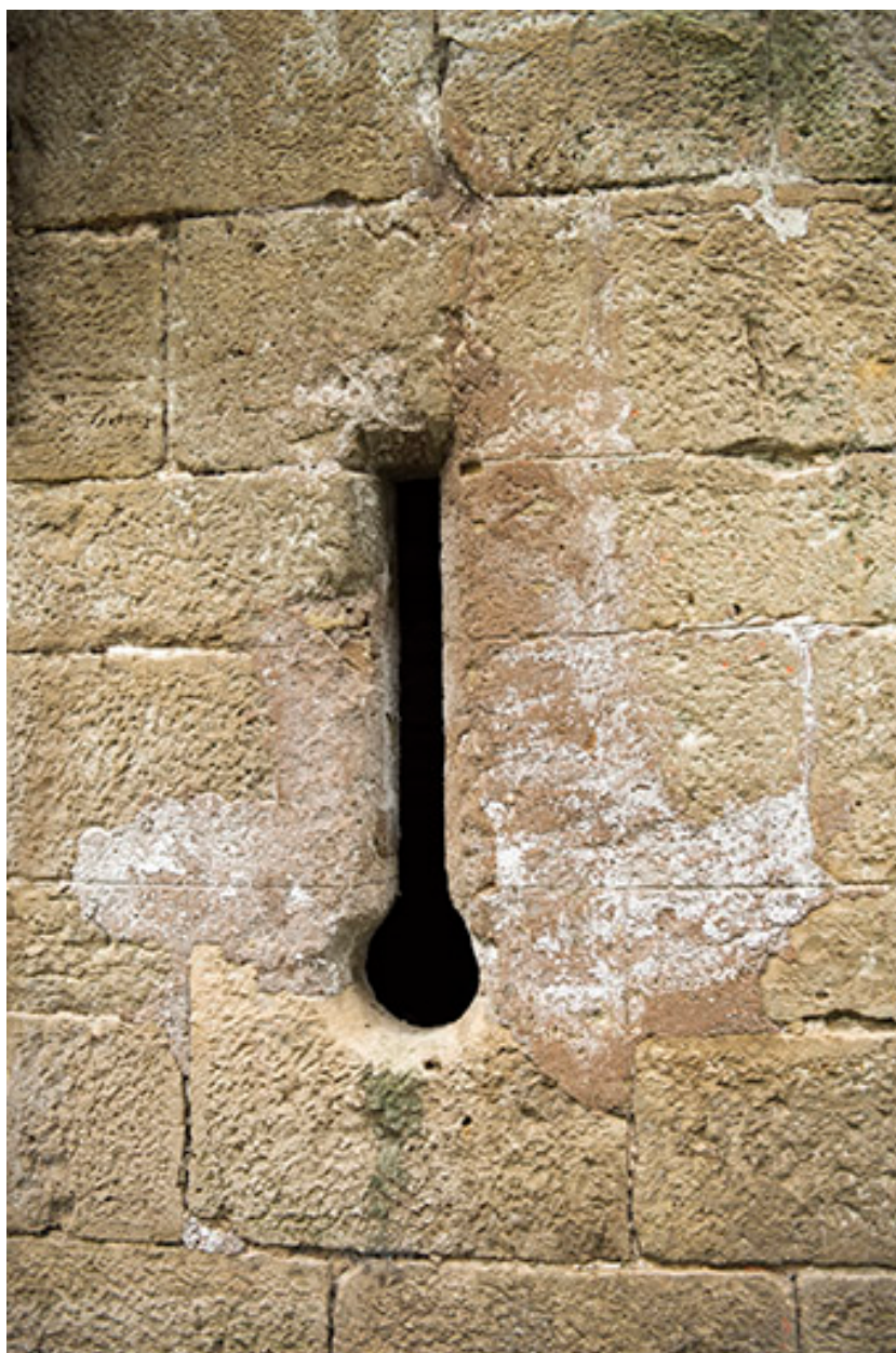
Tour ouest : vue extérieure de la canonnière.
