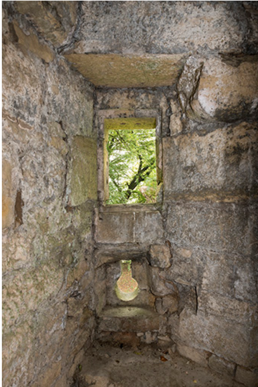
Dans la tour ouest : meurtrière, canonnière.
