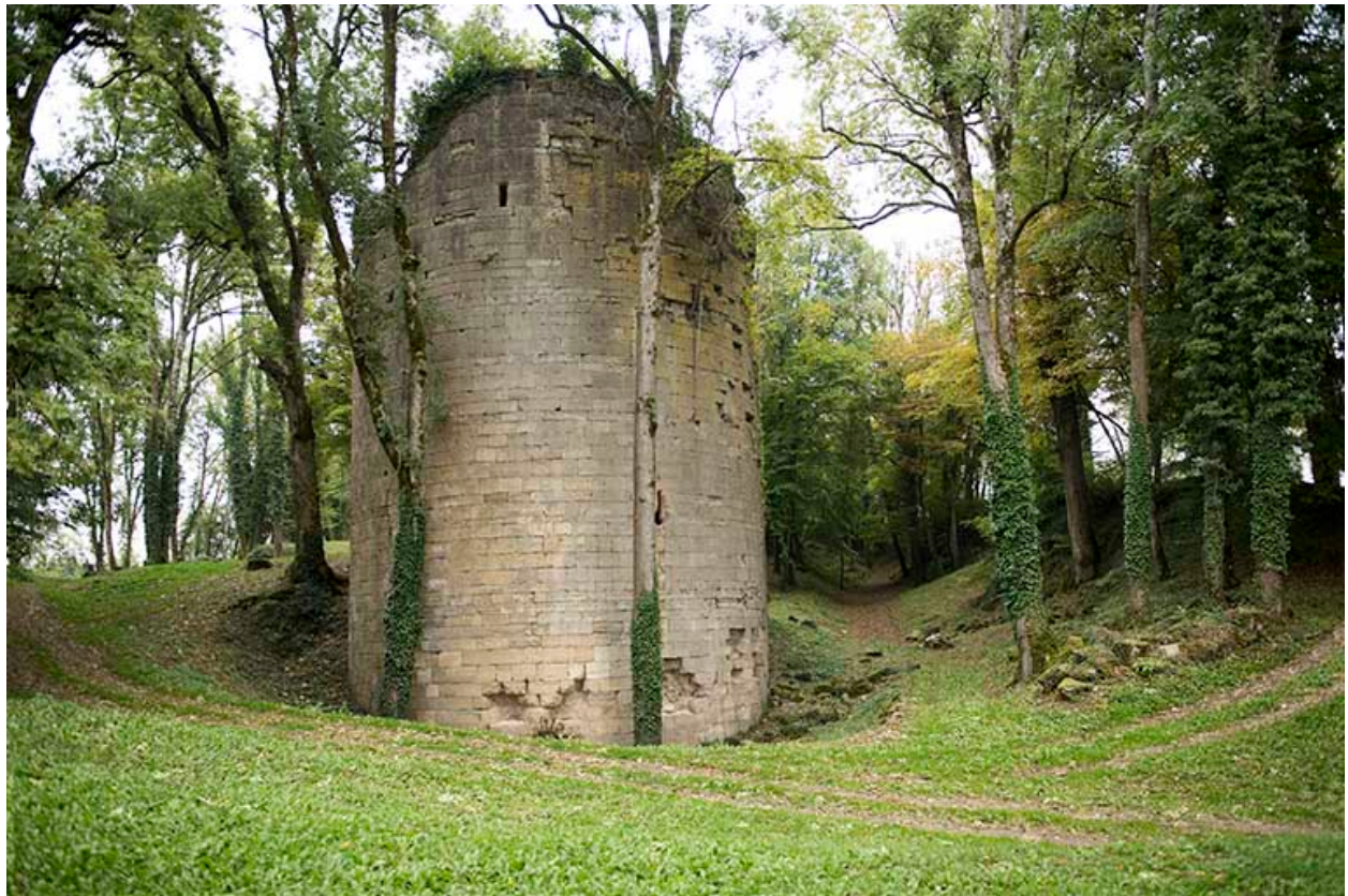
La tour ouest, vue de l'ouest.
