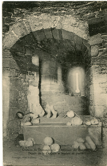
Chateau de Demangevelle. intérieur du donjon. Carte postale ancienne. IVR43_20167000083NUC4A
