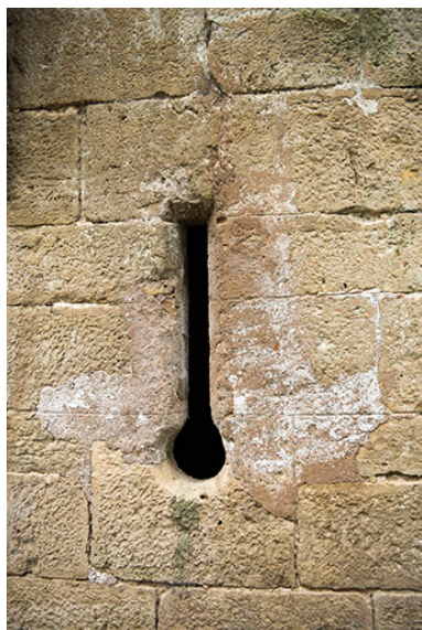
Tour ouest : vue extérieure de la canonnière.
