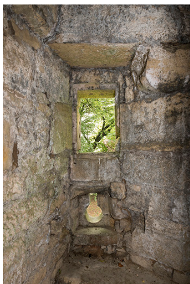
Dans la tour ouest : meurtrière, canonnière.
