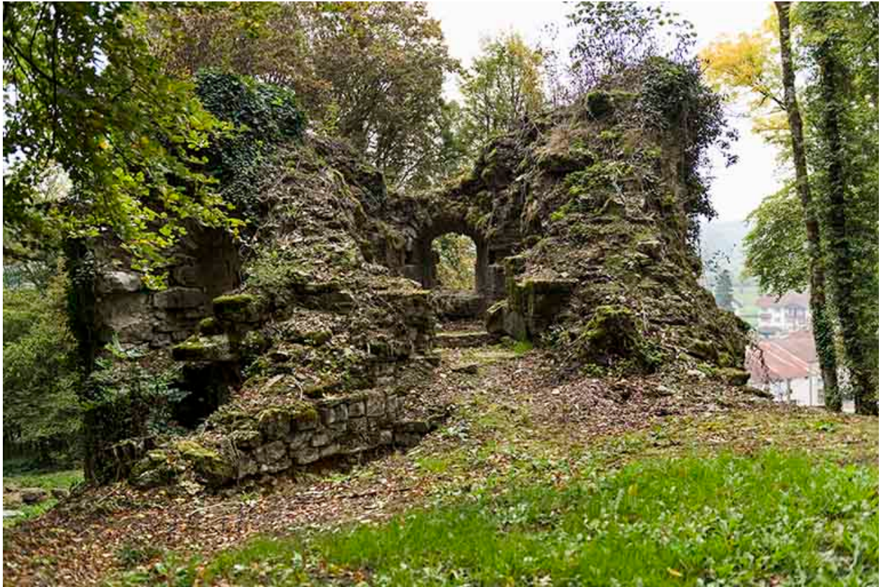
Vue sur la tour est.
