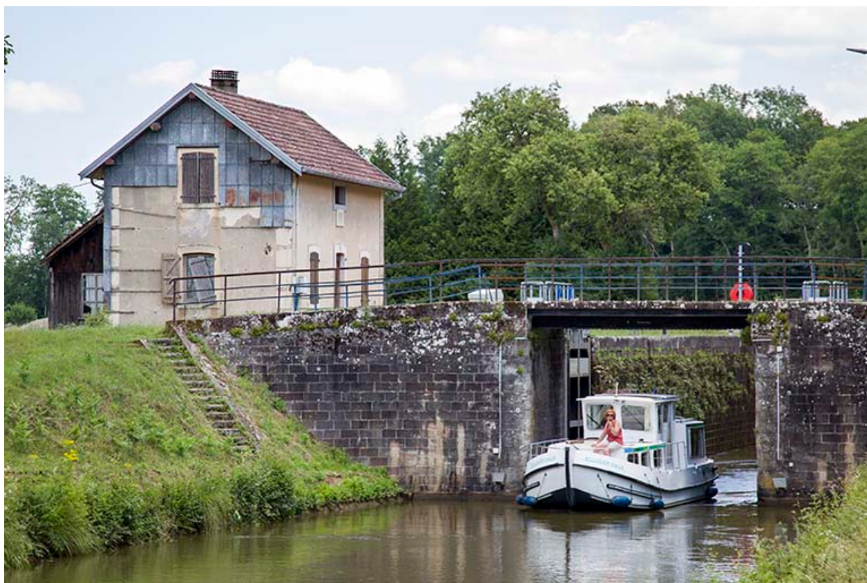
L'écluse, depuis l'aval.
