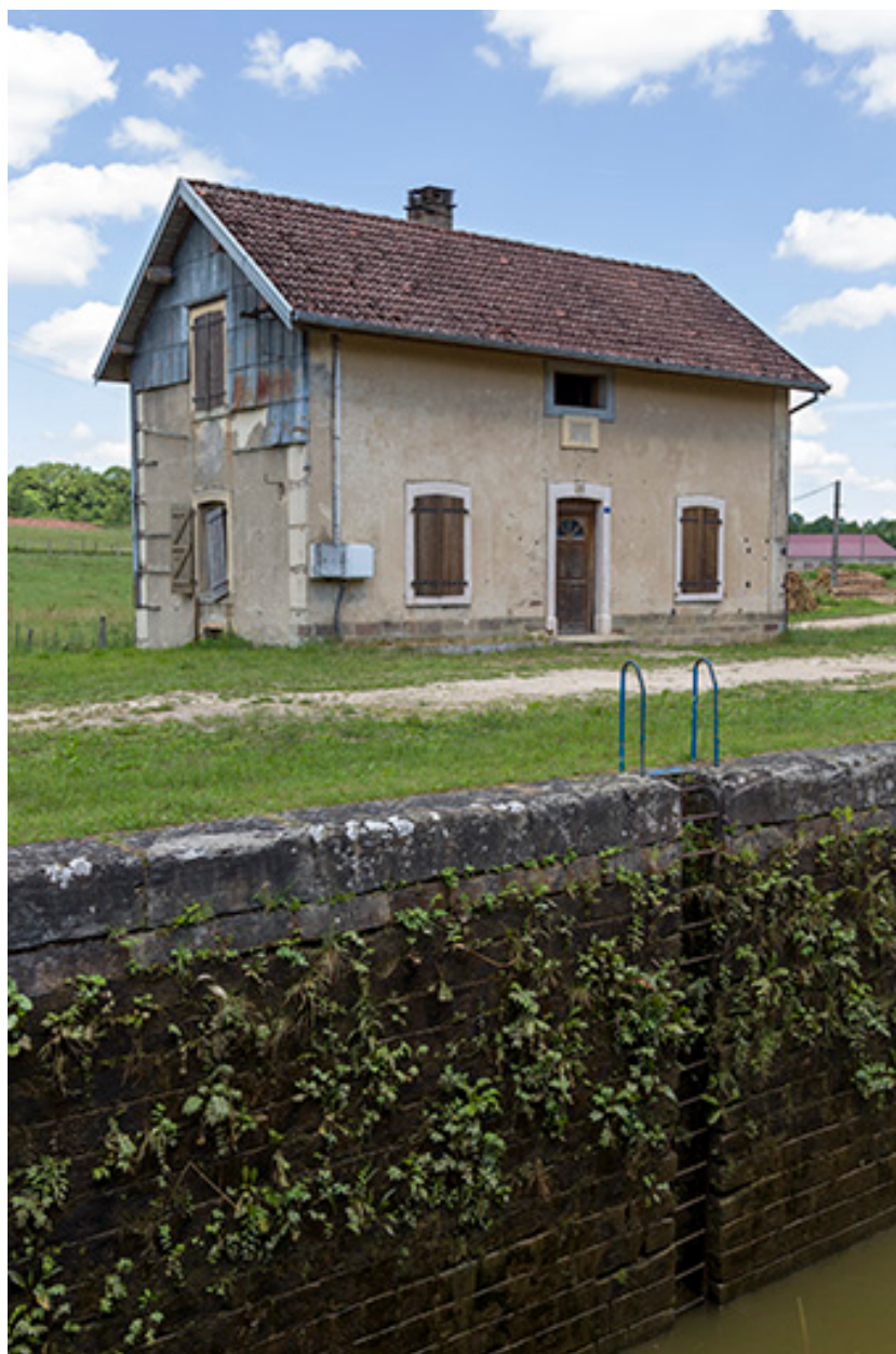
La maison d'éclusier, depuis l'écluse.
