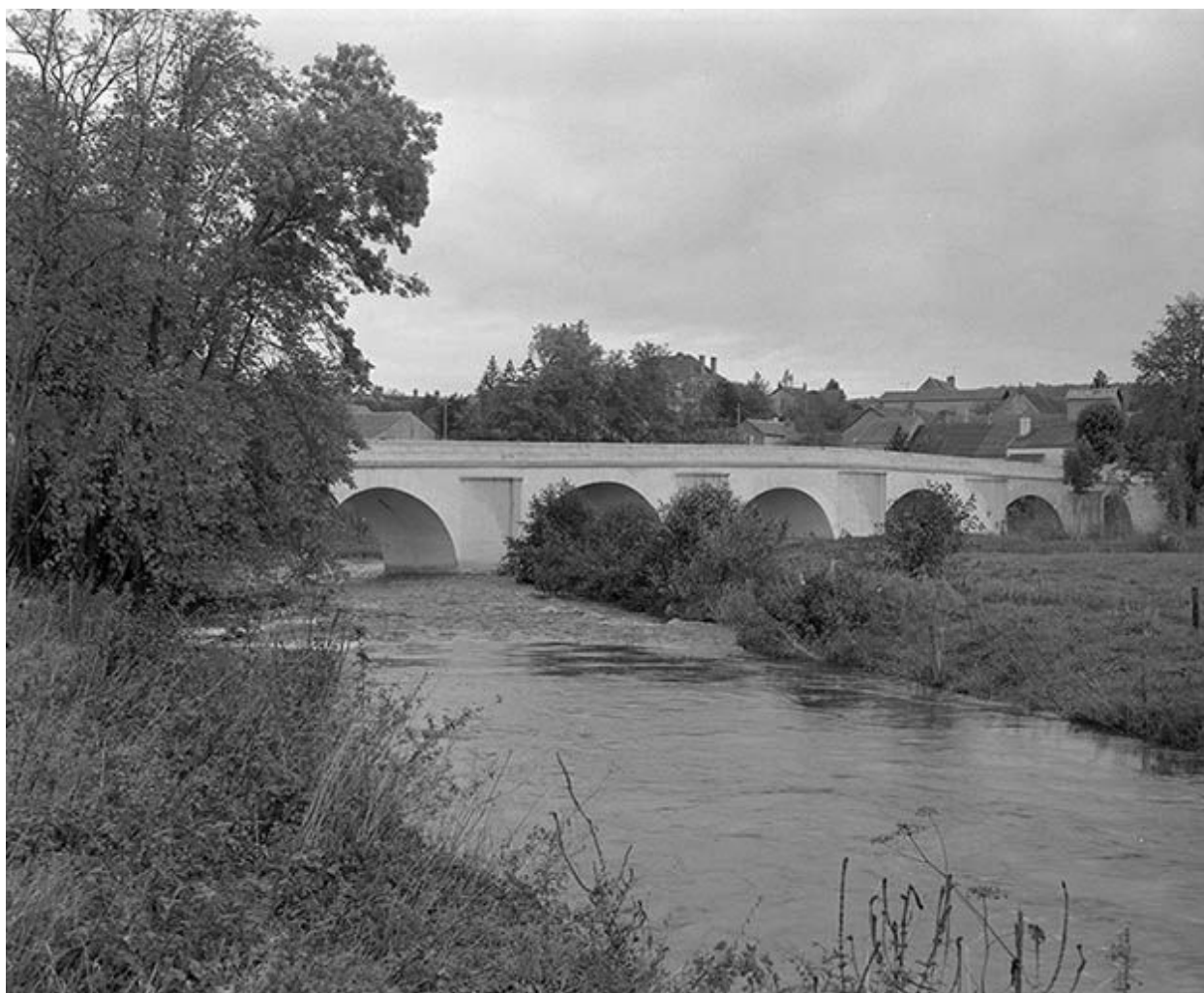
Vue prise de l'amont.
