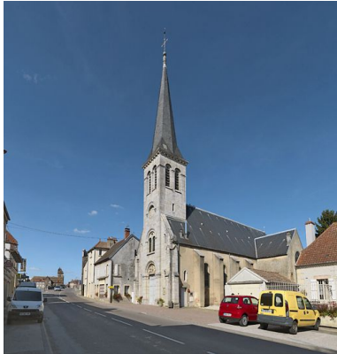
Vue d'ensemble. Phot. Thierry Kuntz IVR26_20112103416NUC4A
