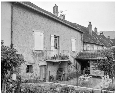
Façade postérieure. Phot. Yves Sancey IVR43_19843900233X
