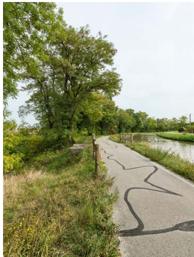
Vue de l'ouvrage.
