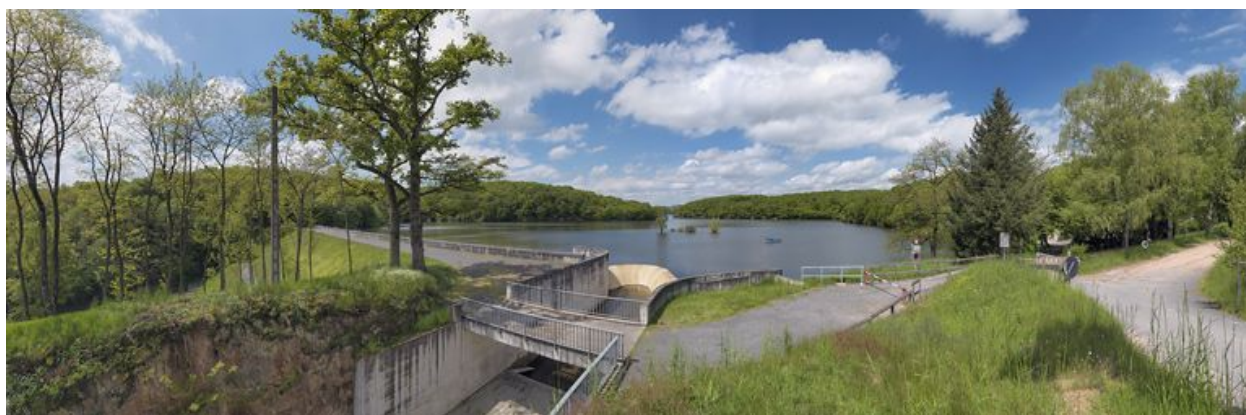
Vue d'ensemble du réservoir.
