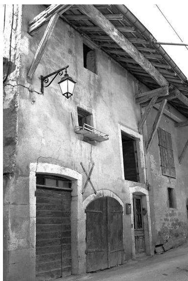
Maison de vigneron située 21 rue Robert Dame. Phot. Yves Sancey IVR43_19802501092X
