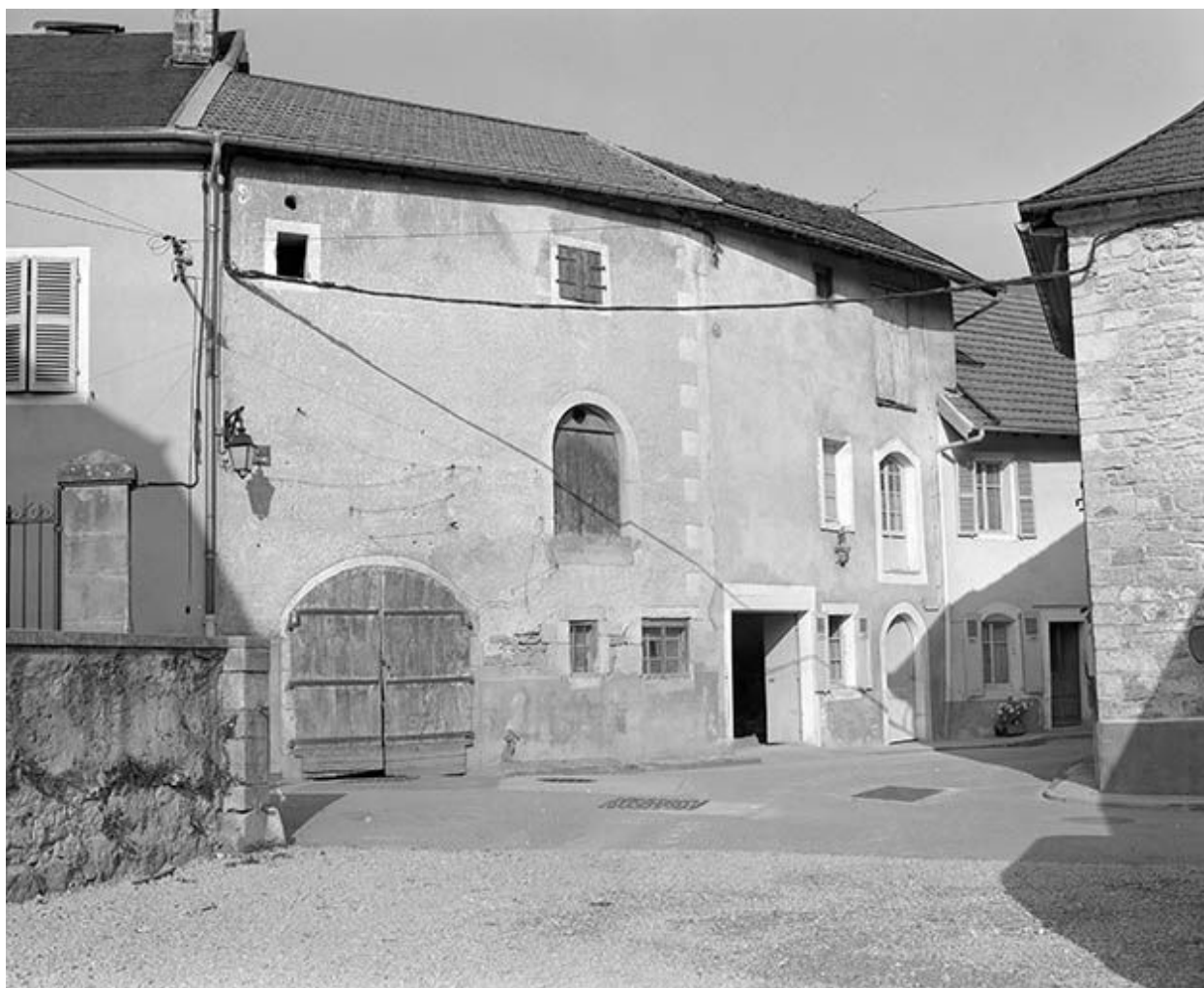
Maison située 2 rue Pavée.
