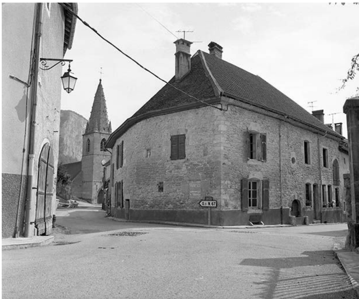
Maison située 3 rue Pavée.
