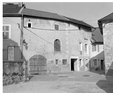
Maison située 2 rue Pavée. Phot. Yves Sancey IVR43_19802501103X
