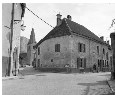
Maison située 3 rue Pavée. Phot. Yves Sancey IVR43_19802501104X
