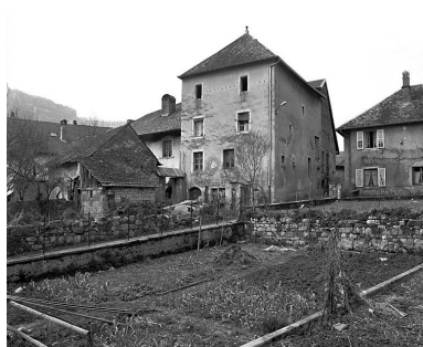
Maison situé rue de la Croix de Sompré. Phot. Yves Sancey IVR43_19822500188X
