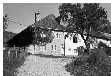
Maison située 8 route de HautePierre. Phot. Yves Sancey IVR43_19802501079X
