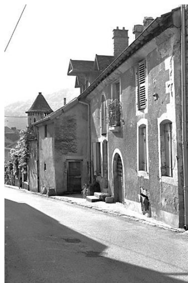
Maison de vigneron située 5 rue Robert Dame. Phot. Yves Sancey IVR43_19802501101X
