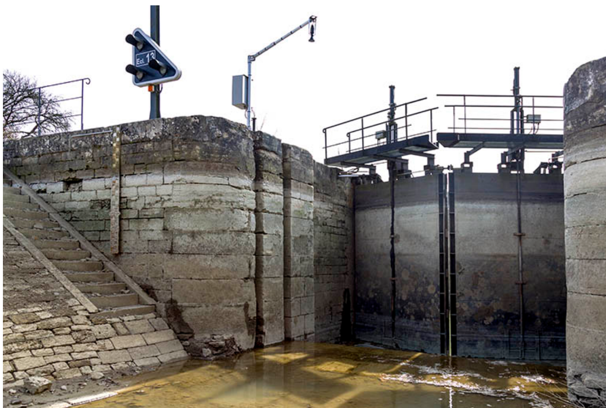
Vue sur la tête amont avec l'estacade de guidage et la porte munie de ses vantaux.
