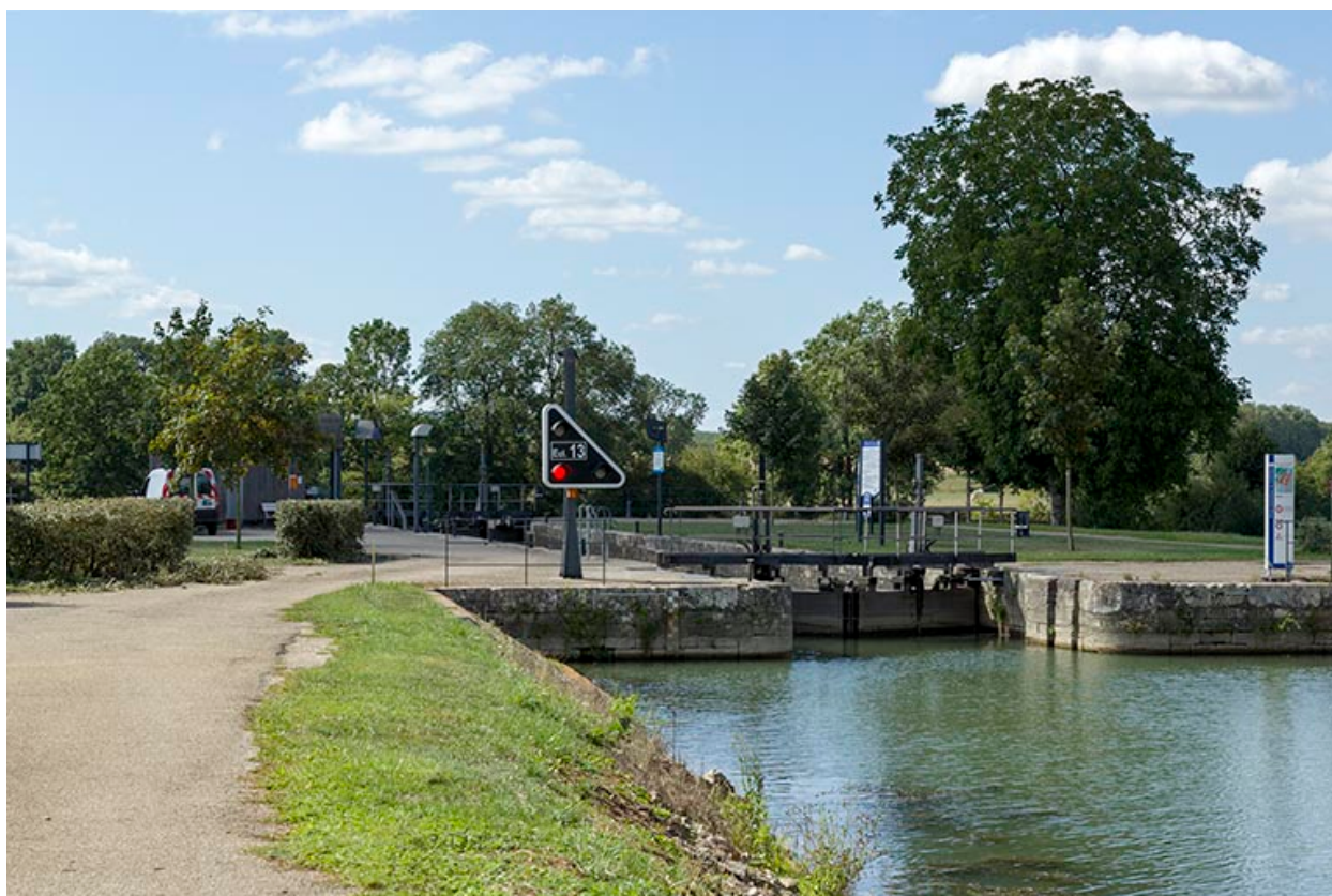
Entrée amont de l'écluse.
