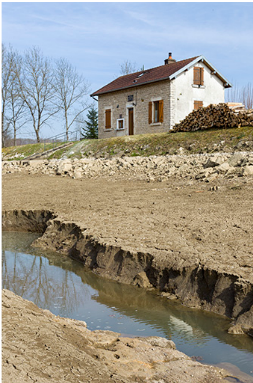
Le chenal de navigation mis hors d'eau.
