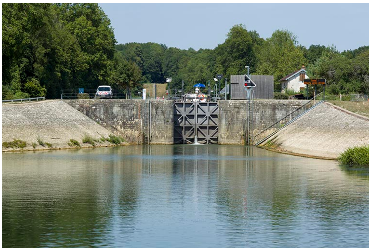
Vue aval, avec les perrés maçonnés.
