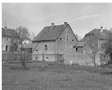
Façade postérieure et façade gauche en 1981. Phot. Yves Sancey IVR43_19813900163X
