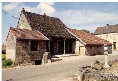
Façade antérieure en 1995. Phot. Jérôme Mongreville IVR43_19953900268ZA
