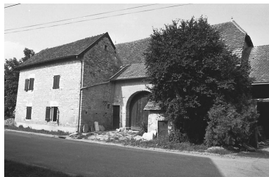
Façade sur rue. Phot. Bernard Lardière IVR43_19797000324Z
