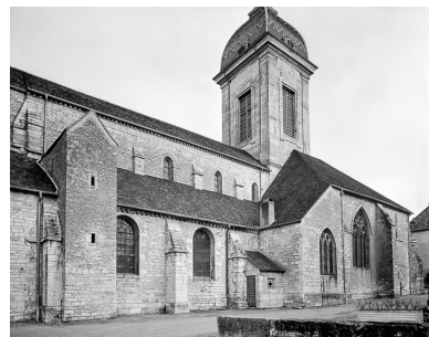
Exérieur : façade latérale sud. Phot. Yves Sancey IVR43_19847000072V
