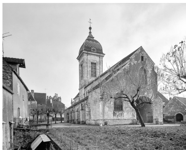
Exérieur : façade ouest. Phot. Yves Sancey IVR43_19847000071V
