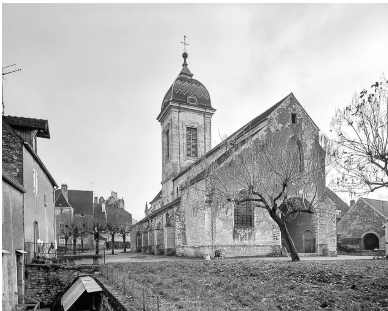
Exérieur : façade ouest.
