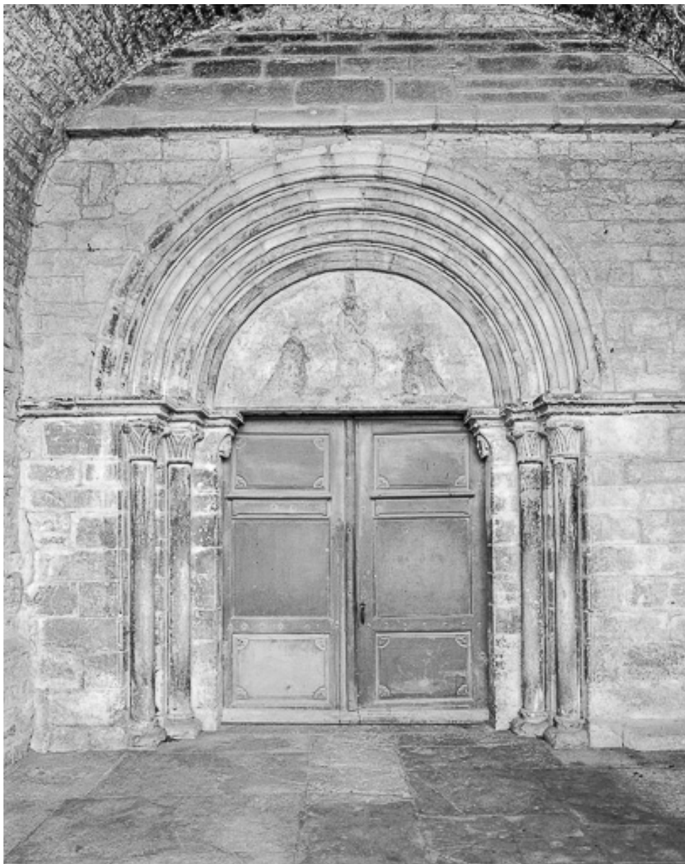
Exétérieur : portail ouest.
