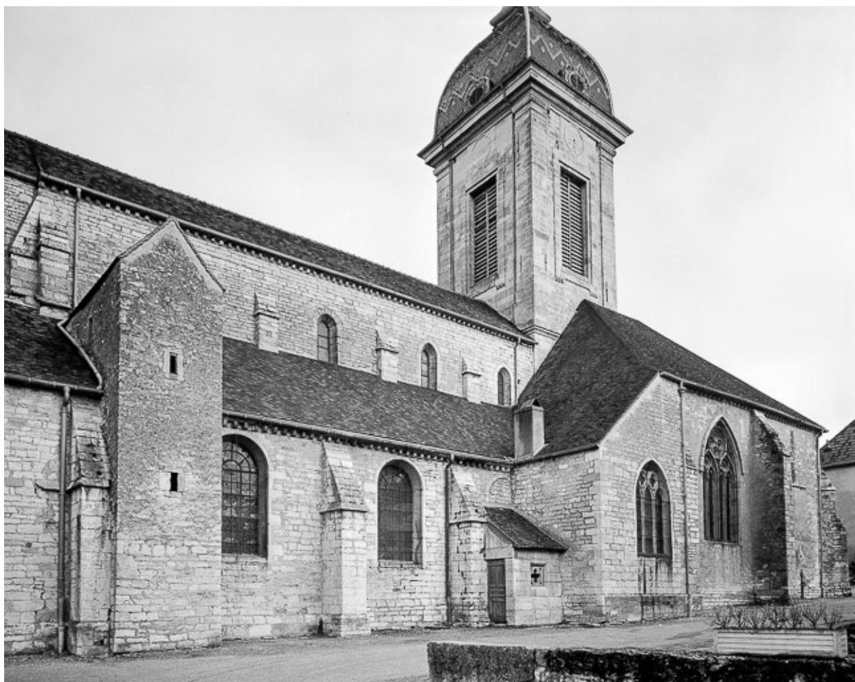
Extérieur : façade latérale sud.
