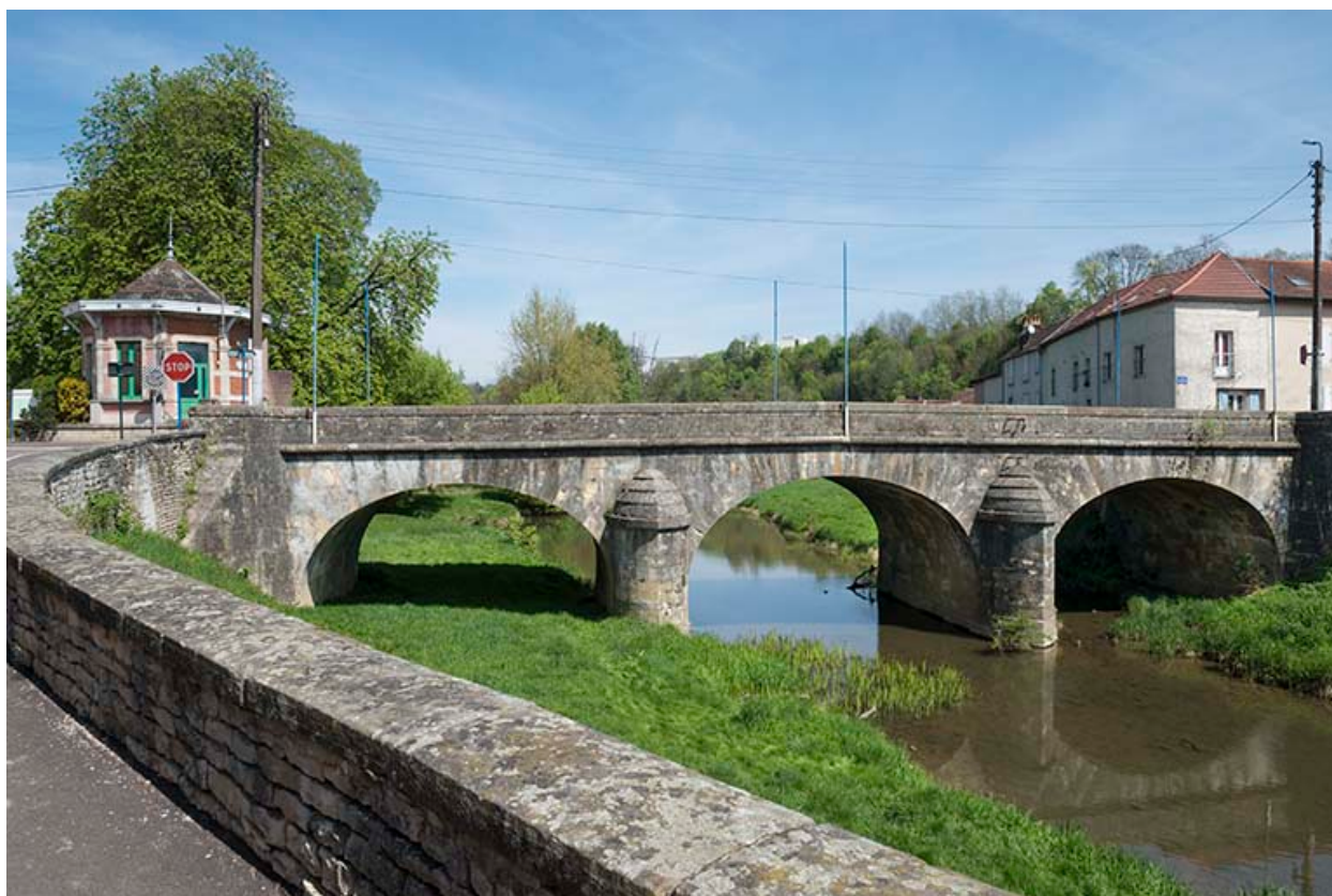
Le pont au niveau de la Rezelle.
