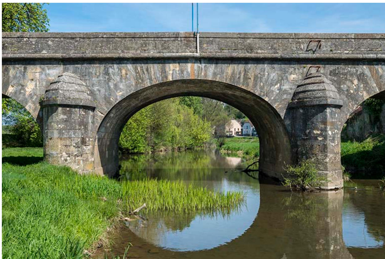
Détail de l'arche centrale.
