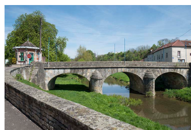
Le pont au niveau de la Rezelle. Phot. Jérôme Mongreville IVR43_20177000705NUC4A
