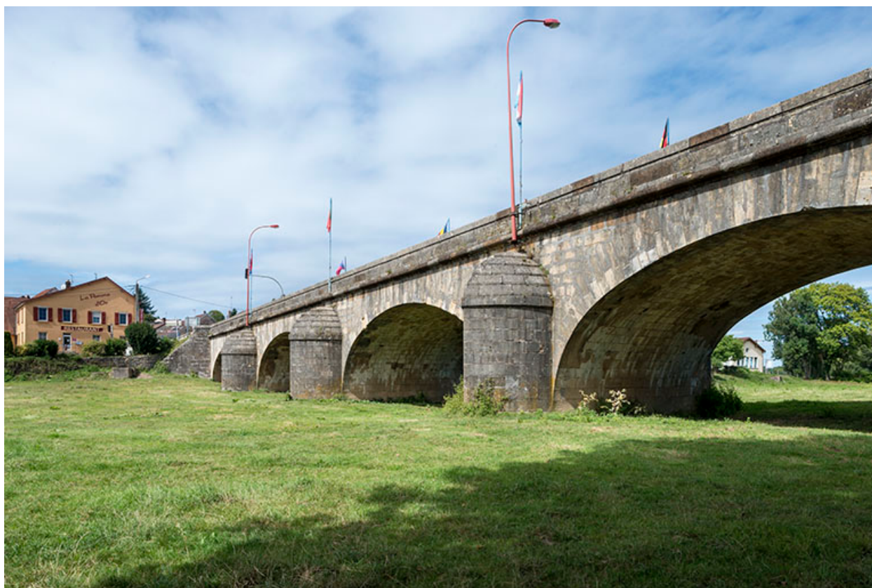
Vue depuis l'aval.
