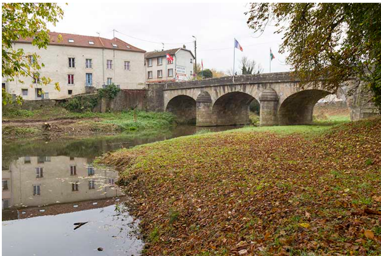
Le pont depuis l'amont.
