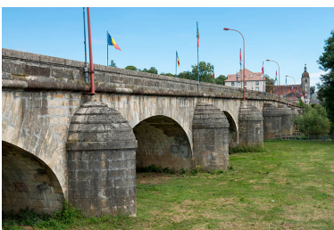
Le pont au niveau de Saint-Valère. Phot. Jérôme Mongreville IVR43_20177001049NUC4A
