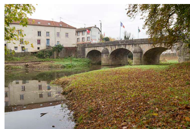
Le pont depuis l'amont. Phot. Sonia Dourlot IVR43_20157000195NUC2A
