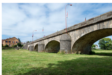
Vue depuis l'aval. Phot. Jérôme Mongreville IVR43_20177001052NUC4A
