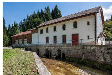
La centrale et le canal de fuite. Phot. Jérôme Mongreville IVR43_20152501767NUC4A
