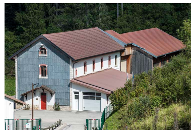
La centrale vue depuis le sud-ouest. Phot. Jérôme Mongreville IVR43_20152501764NUC4A
