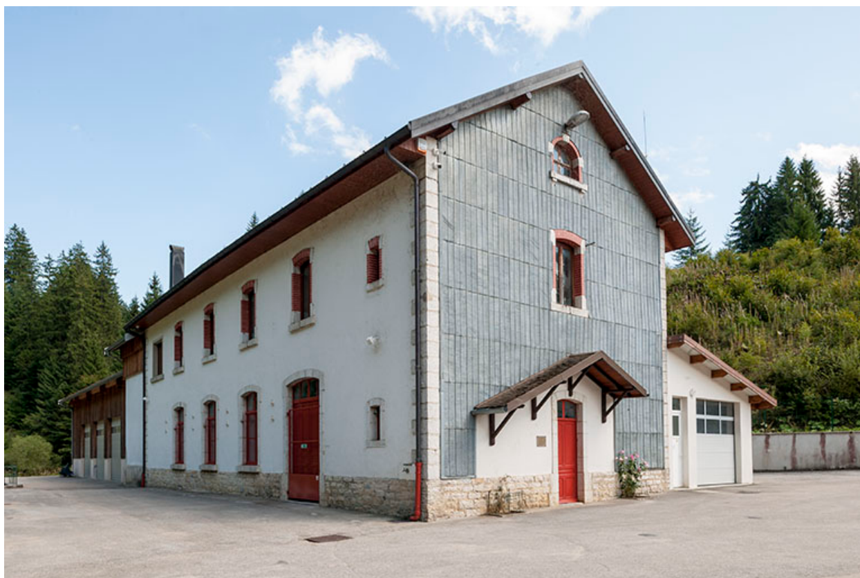
Centrale vue de trois quarts droite.
