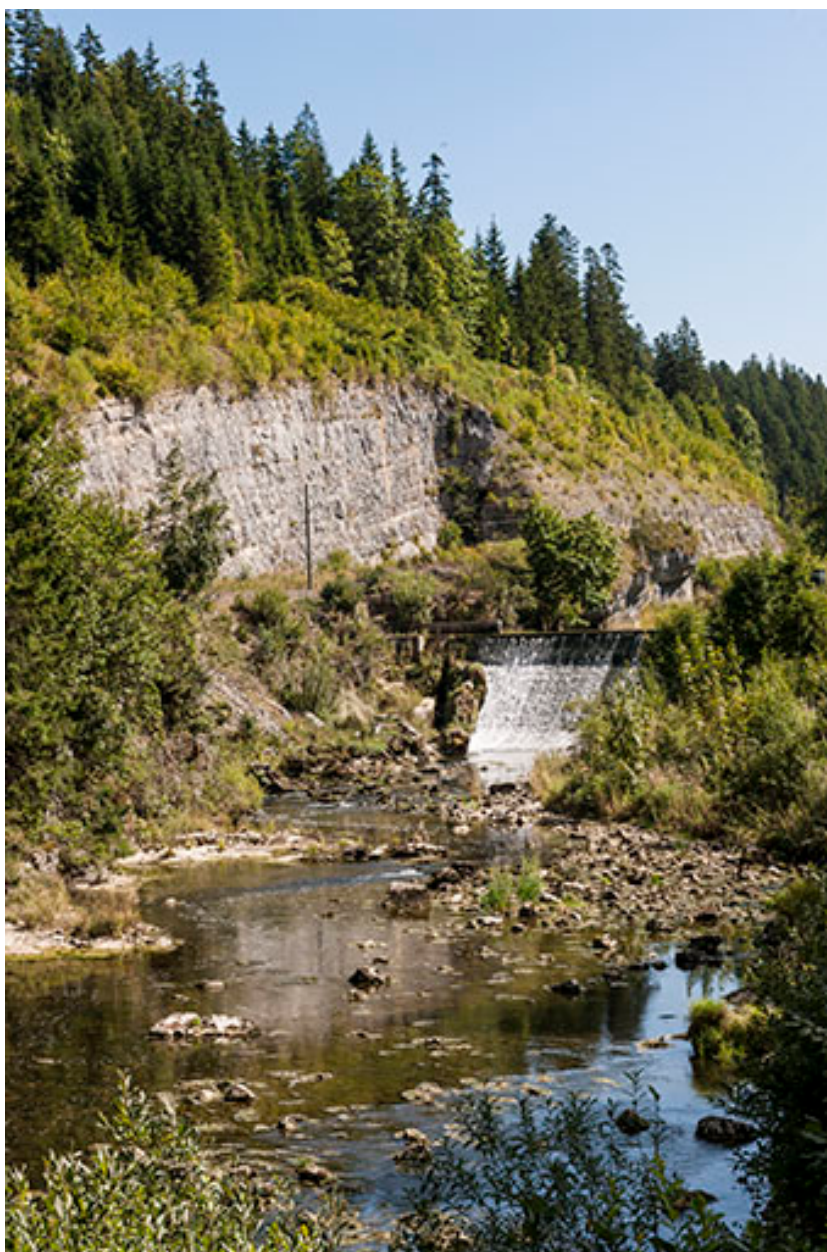
Le barrage dans les gorges de Fourpéret.
