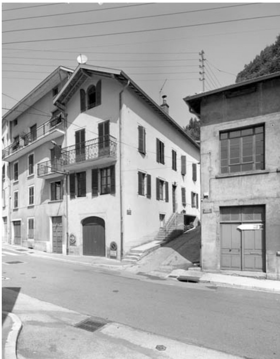
Vue d'ensemble depuis la rue Rosset.
