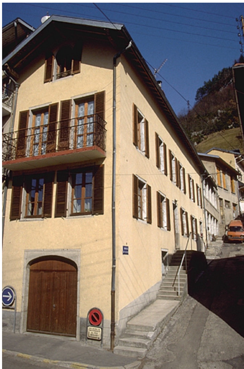
Vue d'ensemble depuis la rue Rosset.
