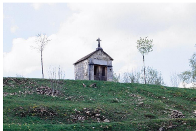
Vue générale. Phot. Yves Sancey IVR43_19993900239ZA
