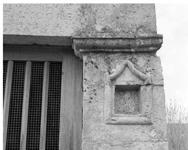
La niche du piédroit de la porte. Phot. Yves Sancey IVR43_19993900244X
