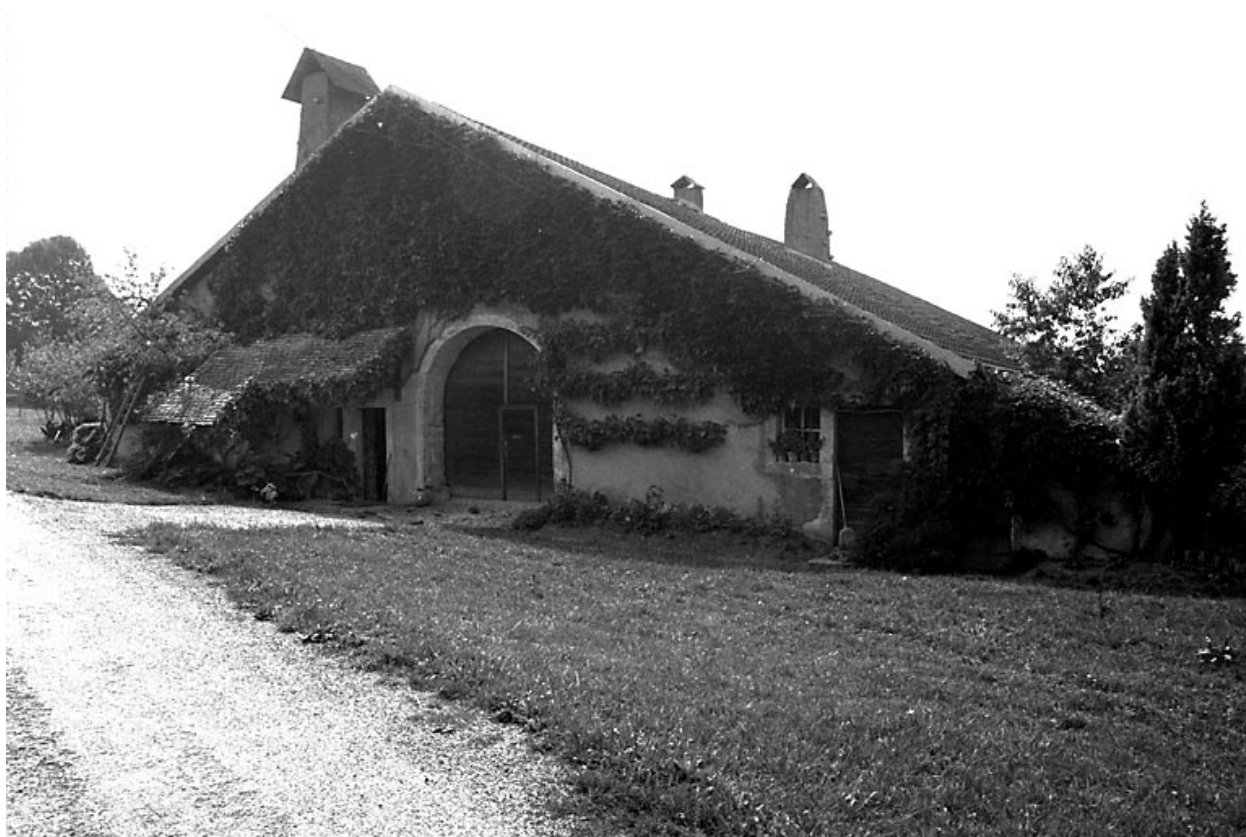
Ferme située au lieudit Bois-Vieille.
