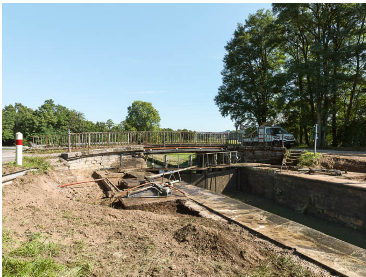
Vue d'ensemble du pont.
