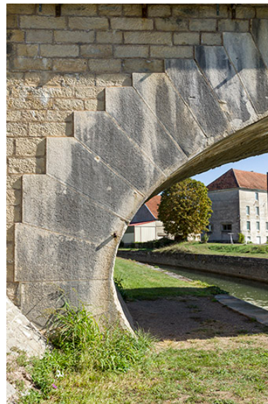
Détail sur la maçonnerie. Phot. Sonia Dourlot IVR43_20167001784NUC2A
