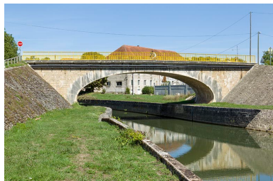
Vue générale de l'édifice depuis l'aval. Phot. Sonia Dourlot IVR43_20167001781NUC2A
